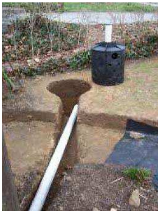
Figura 9 - Poço seco em construção
