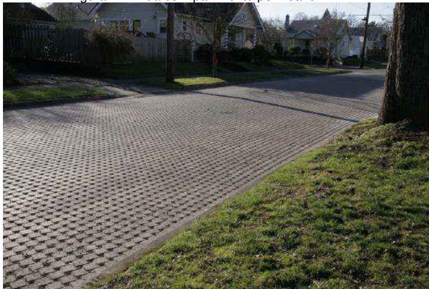
Figura 17 - Rua com pavimento permeável
