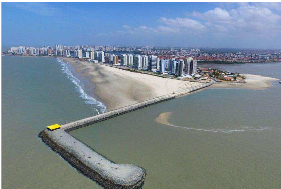
Figura 49 - Espigão localizado na Ponta D'Areia
