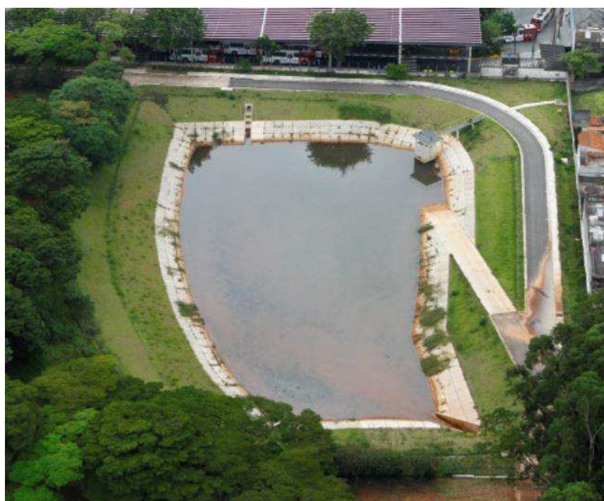
Figura 18 - Exemplo de Bacia de Retenção
