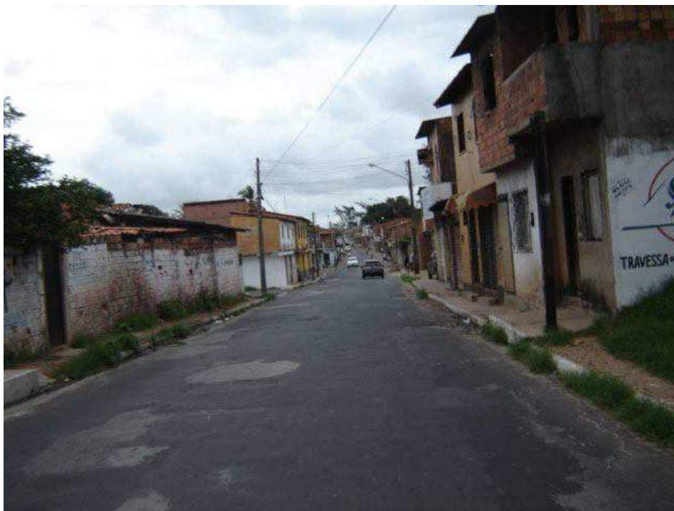
Figura 14 Estrada da Vitória, próximo ao Hospital Sarah Fonte: Jales, 2006
