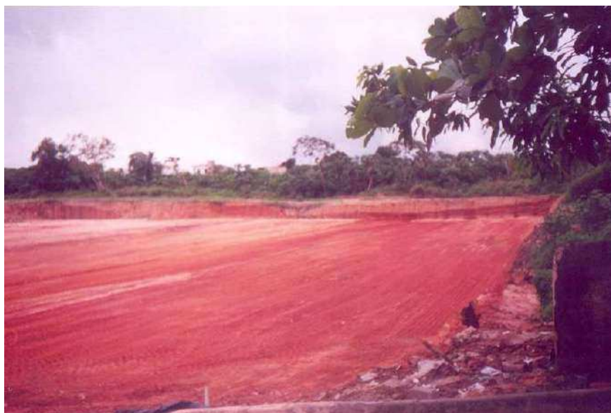
Foto 17: vista em direção dos fundos do terreno
