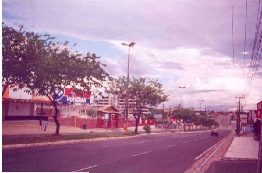
Foto 13: acesso pela Avenida Daniel de La Touche, com entorno predominantemente comercial
