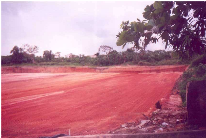
Foto 17: vista em direção dos fundos do terreno
