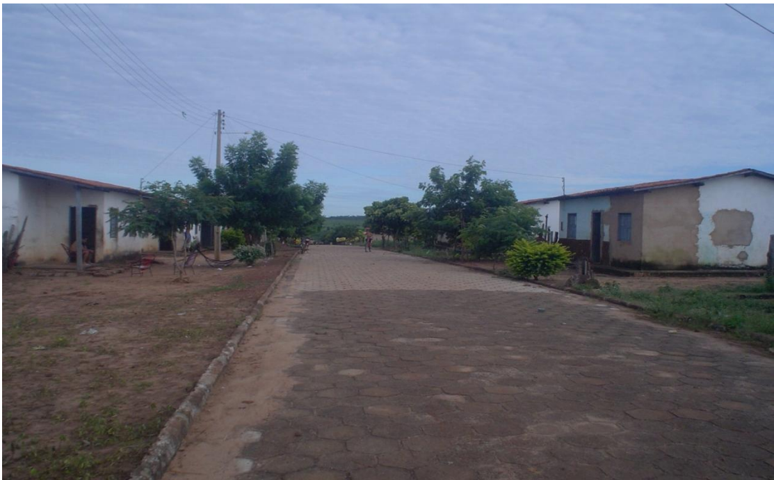
Figura 8 - Rua pavimentada e meio fio no assentamento
