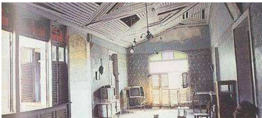
Figura 19 - Sala superior da parte residencial do Laboratório João Victal de Mattos, 1982 Fonte: Arquitetura Luso-Brasileira no Maranhão, 1998, p.39
