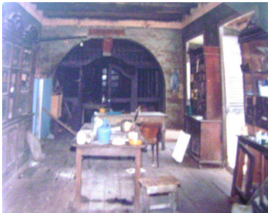
Figura 15 - Sala do térreo, arcada ao fundo com a cancela de madeira Fonte: Processo de Inspeção, 2005 IPHAN
