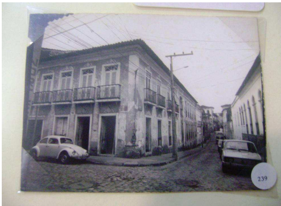
Figura 7 – Farmácia João Victal de Mattos, 1987 Fonte: Processo de Inspeção, IPHAN
