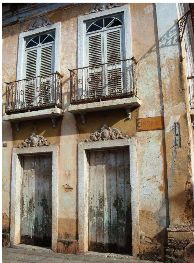
Figura 13– Janelas, sacadas e portas da fachada principal Fonte: http://www.panoramio.com/
