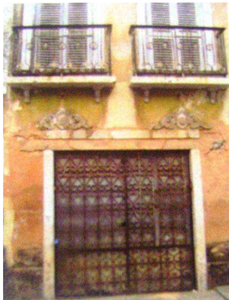
Figura 20 – Descaracterização da abertura para garagem realizada pela proprietária Fonte: Processo de Inspeção, 2005 IPHAN
