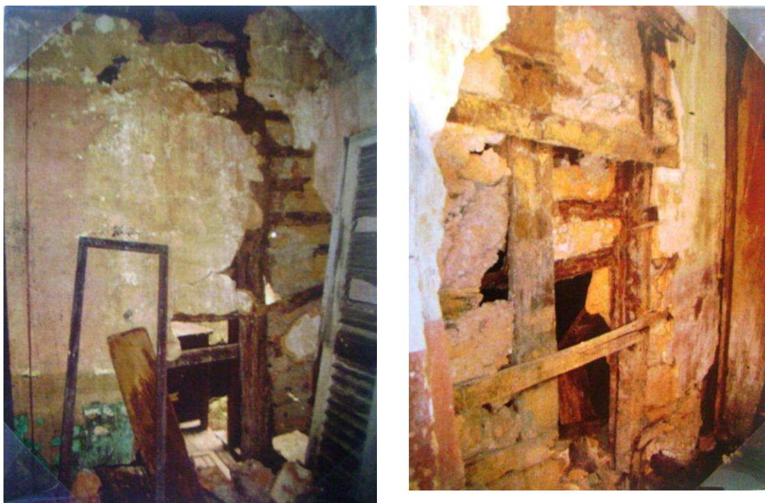
Figura 32 - Alvenaria de taipa de pilão Fonte: Fonte: Processo de Inspeção, IPHAN, 2005
