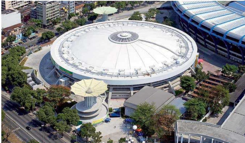
Figura 9 - Vista da cobertura do Ginásio Maracanãzinho.
