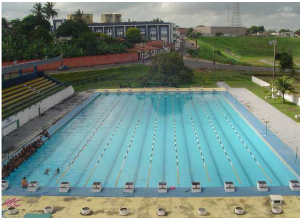
Figura 18 - Piscina do Complexo do Castelão.
