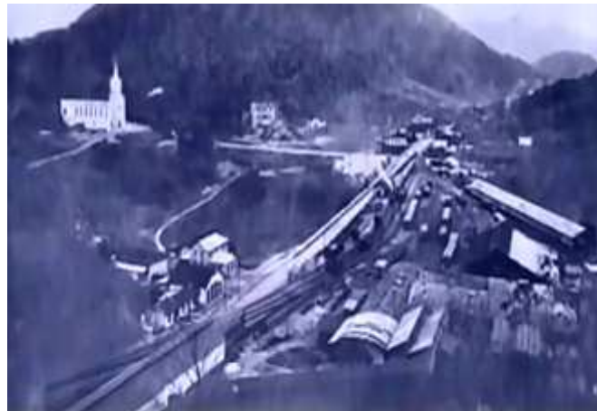
Figura 3 – Construção da estrada de ferro do Barão de Mauá
