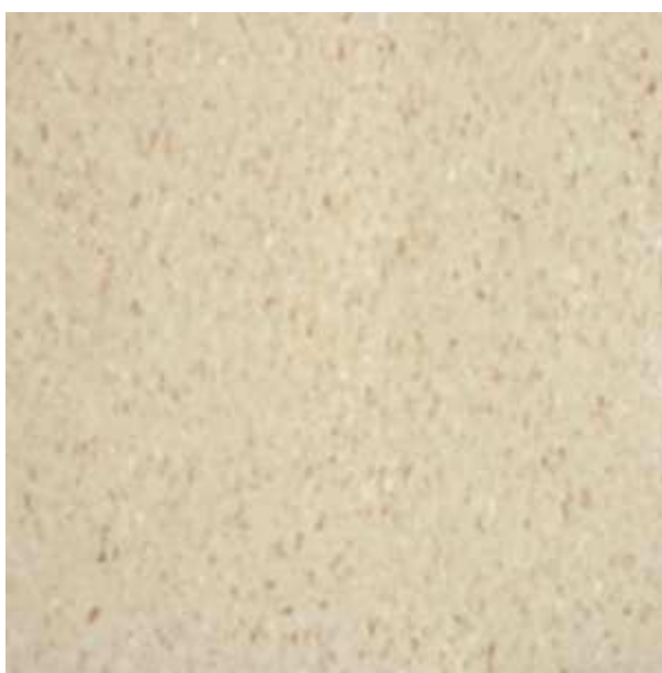
Figura 97 – Piso Paviflex, textura Reno, utilizado no corredor
