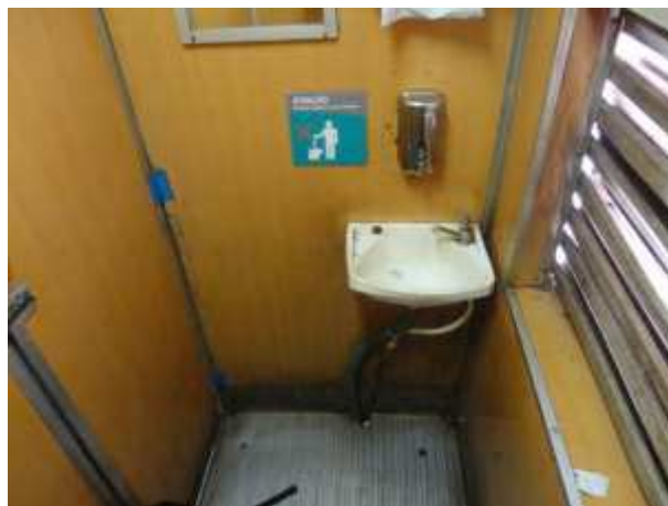
Figura 60 – Banheiro da classe econômica tipologia 2
