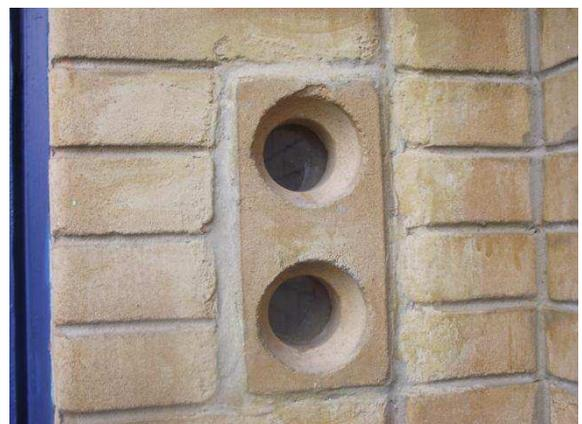
Figura 20 – Tijolos assentados na vertical a fim de garantir passagem de iluminação natural par ao interior da Casa. Fonte: A autora, 2011.
