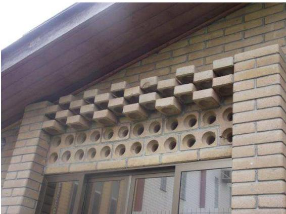
Figura 19 – Moldura em tijolos ecológicos na janela frontal da Casa Ecológica. Fonte: A autora, 2011.
