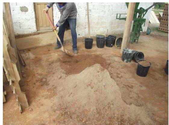
Figura 41 – Preparação da mistura de barro, cimento e água. Fonte: A autora, 2012.
