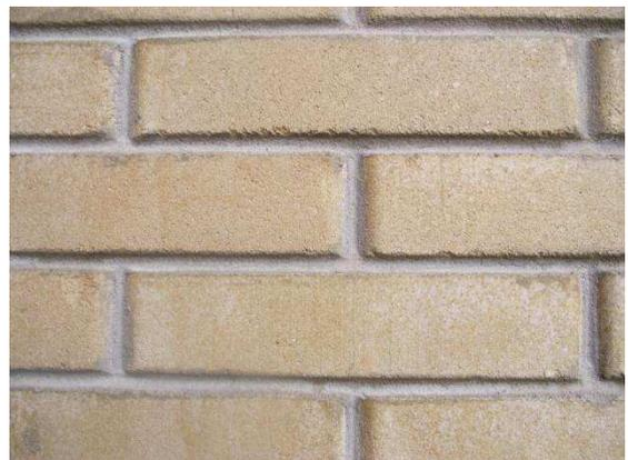
Figura 17 – Parede da Casa Ecológica com os tijolos assentados com nata em cimento magro. Fonte: A autora, 2011.
