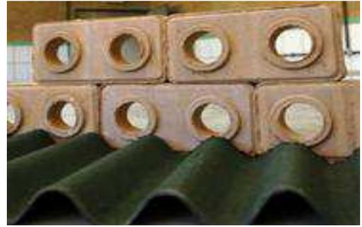
Figura 11 – Materiais usados na Casa Ecológica do IVIG. Tijolos de solo-cimento e telha de fibra vegetal. Fonte: [www.ivig.com.br](http://www.ivig.com.br)
