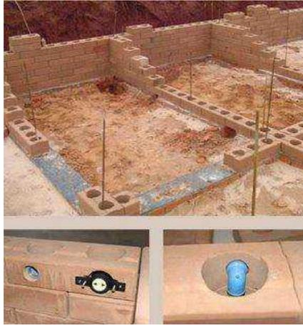
Figura 54 – Primeira fiada de tijolos com a passagem dos vergalhões e instalação elétrica e passagem de tubulação hidráulica pelos tijolos. Fonte: Googleimagens.
