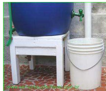
Figuras 63 e 64 – Minicisterna sobre apoio em madeira, para permitir a retirada da água coletada. Fonte: [www.sempresustentavel.com.br](http://www.sempresustentavel.com.br)
