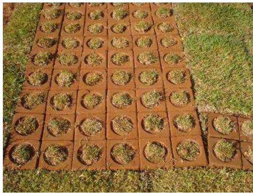
Figura 55 – Piso grama em solo-cimento. Fonte: [http://www.verdesaine.net/piso\\_grama\\_de\\_solo\\_cimento](http://www.verdesaine.net/piso_grama_de_solo_cimento)
