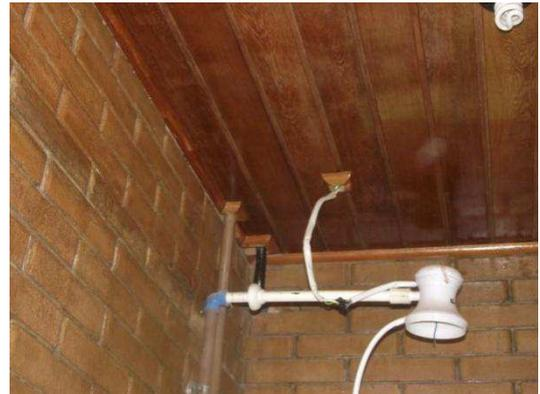
Figura 15 – Detalhe do forro do banheiro com tubulação hidráulica aparente. Fonte: A autora, 2011.
