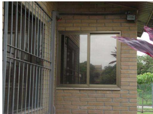
Figura 28 – Detalhe das esquadrias do protótipo atual: vidro e alumínio na composição. Fonte: A autora, 2011.
