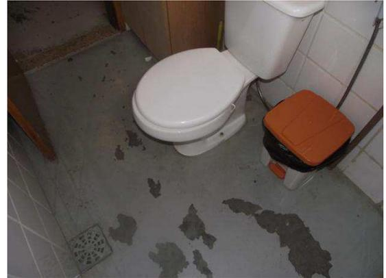
Figuras 23 e 24 – Piso da Sala e banheiro com arranhões e desgaste. Fonte: A autora, 2011.
