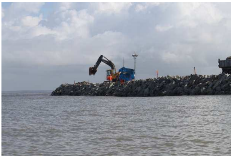
Figura 32 – Execução do Espigão. Fonte: Arquivo Próprio. 2011
