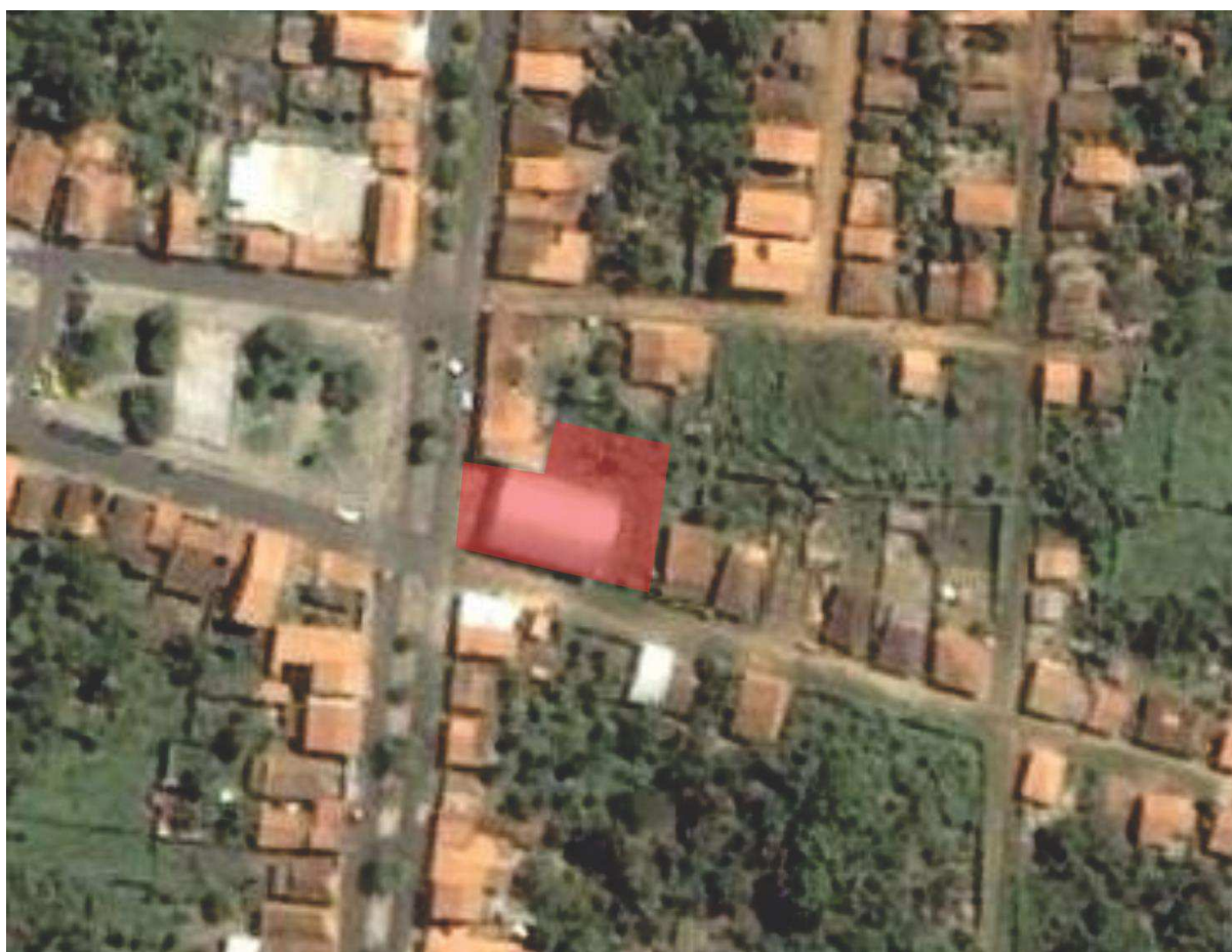
Foto 22 – Vista aérea da área de intervenção Fonte: Google earth com modificações do autor, 2012
