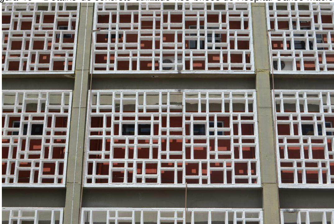
Figura 46 – Detalhe do concreto utilizado nos brises do Hospital Carlos Macieira.
