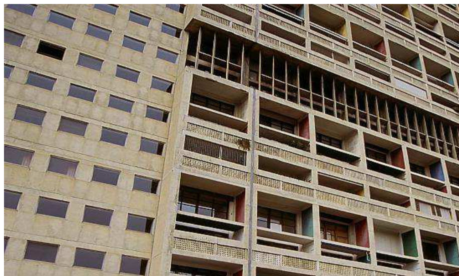
Figura 10 – Brises da Unidade de Habitação em Marselha.
