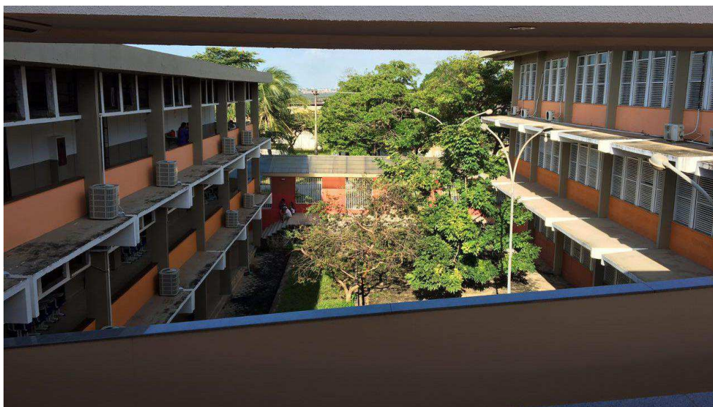
Figura 34 – CCSO vista interna.
