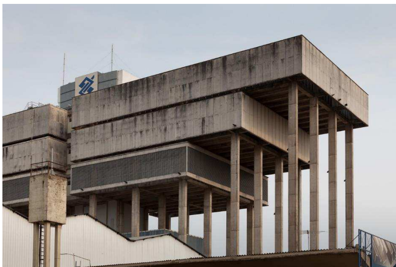
Figura 31 – Centro de Mecanização do Banco do Brasil, RS.
