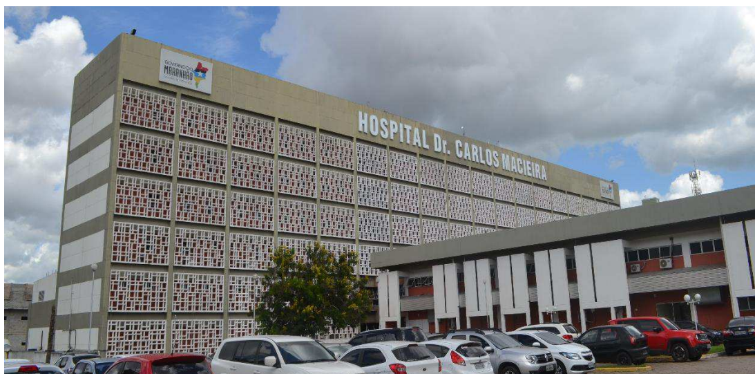
Figura 45 – Hospital Carlos Macieira.
