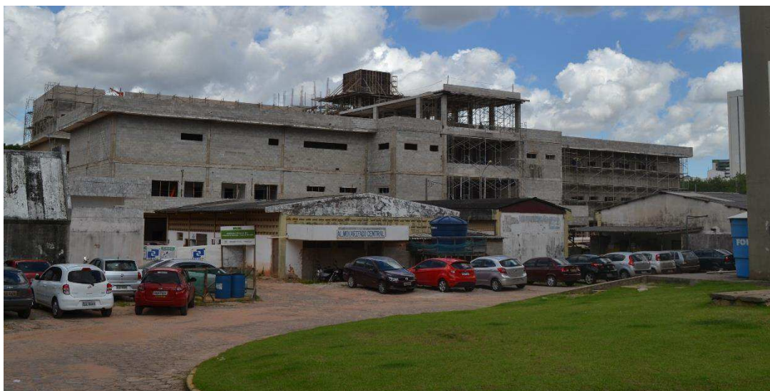
Figura 49 – Foto da construção da ampliação do Hospital Carlos Macieira.
