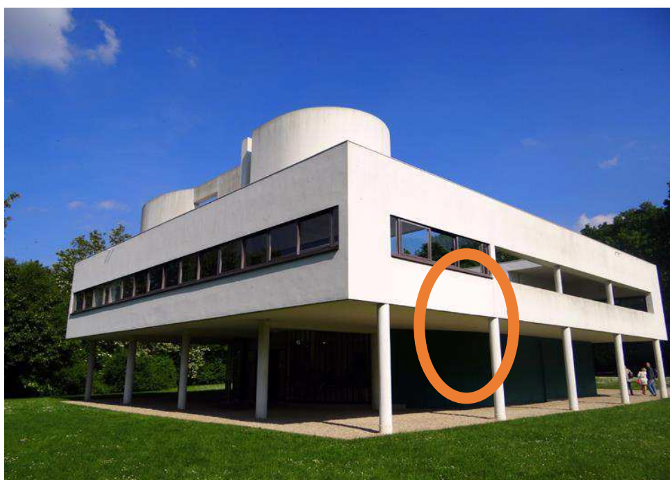
Figura 13 – Villa Savoy de Le Corbusier com demarcação dos pilares pela autora.
