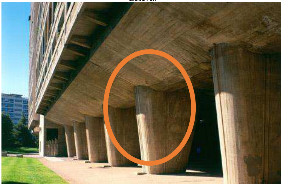
Figura 14 – Unidade de Habitação de Marselha com demarcação dos pilares pela autora.
