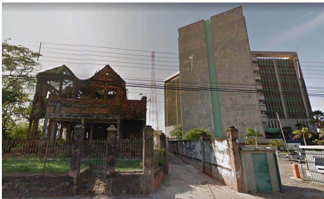
Figura 55 – Chalé da Fabril em ruínas ao lado do Ministério da Fazenda.
