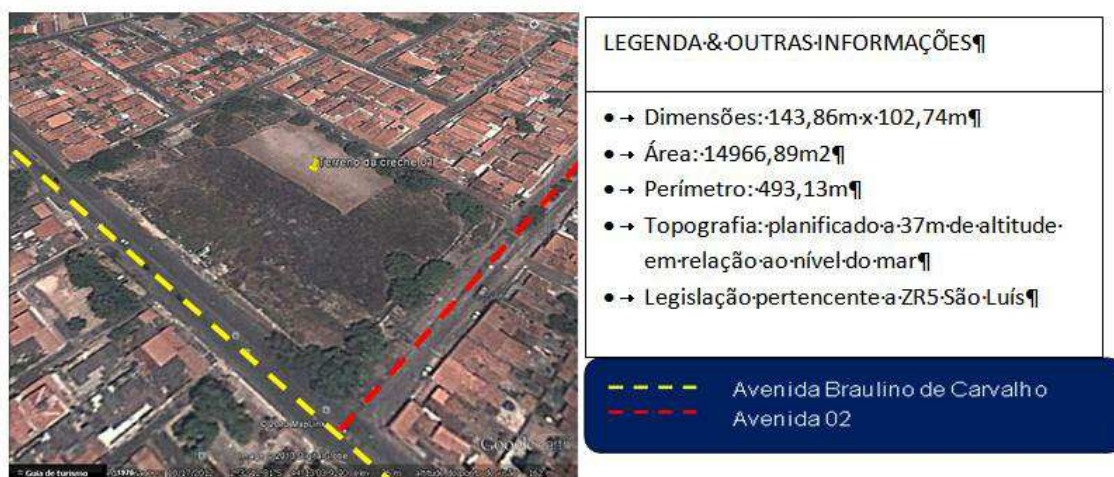
Figura 18 - Vista aérea do Terreno a ser utilizado
