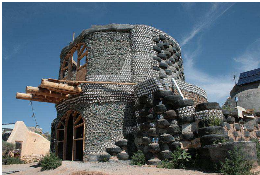
Figura 02: Casa construída a base de materiais reciclados
