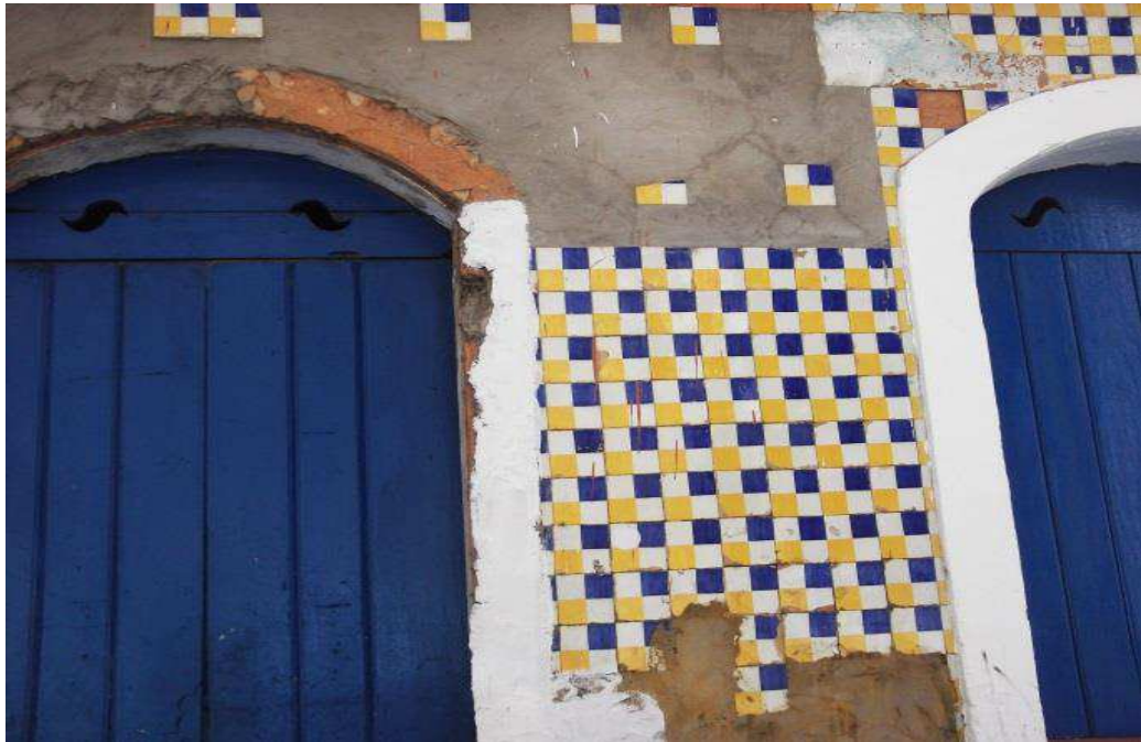
Fig. 35 Lacunas preenchidas com cimento Portland Fonte: Autora , 2013
