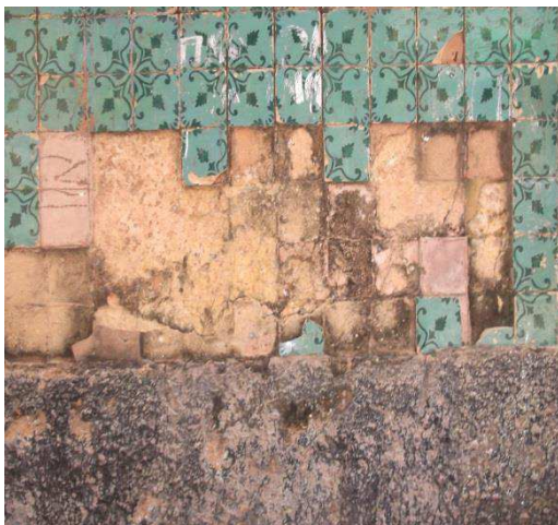
Figs. 18, 19, 20 e 21 Estado de Conservação dos azulejos da fachada
