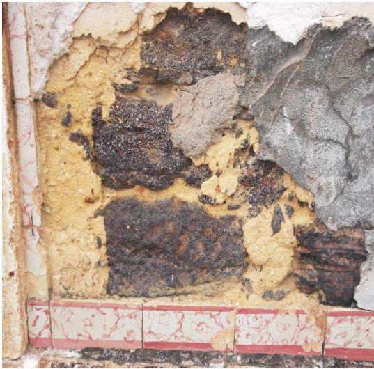
Fig. 46 Detalhe do preenchimento com cimento Portland Fonte: Autora, 2013
