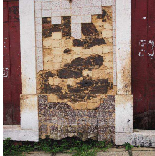
Fig. 47 Detalhe da fachada
