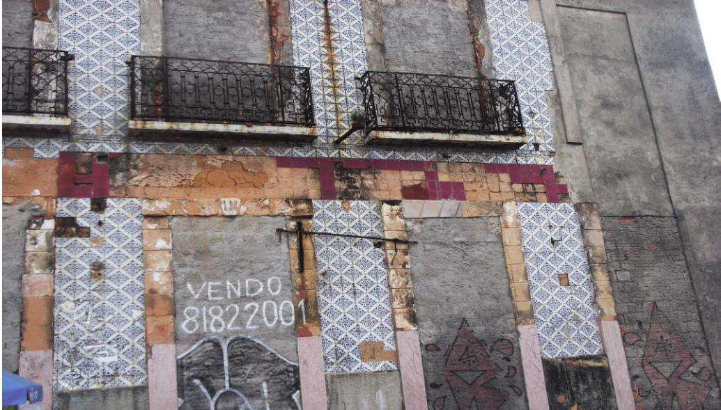
Fig. 64 Detalhe da fachada principal da Praça João Lisboa, 200
