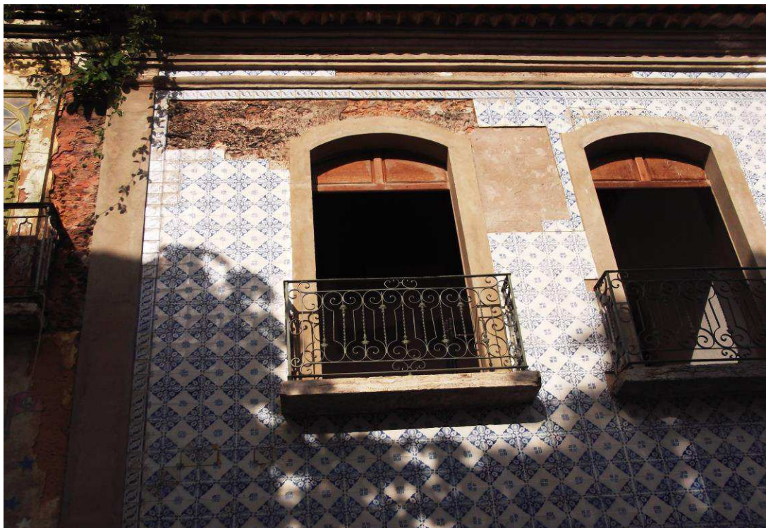
Fig. 12 Detalhe da fachada onde foi retirada a árvore - Rua do Giz, 53
