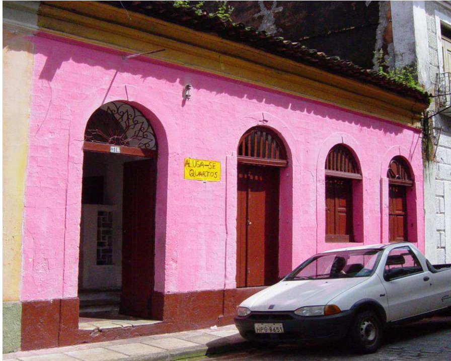
Fig. 57 Fachada azulejada pintada com tinta acrílica - Rua Afonso Pena, 310 Fonte : Inventário do Patrimônio Azulejar do Maranhão, 2012.
