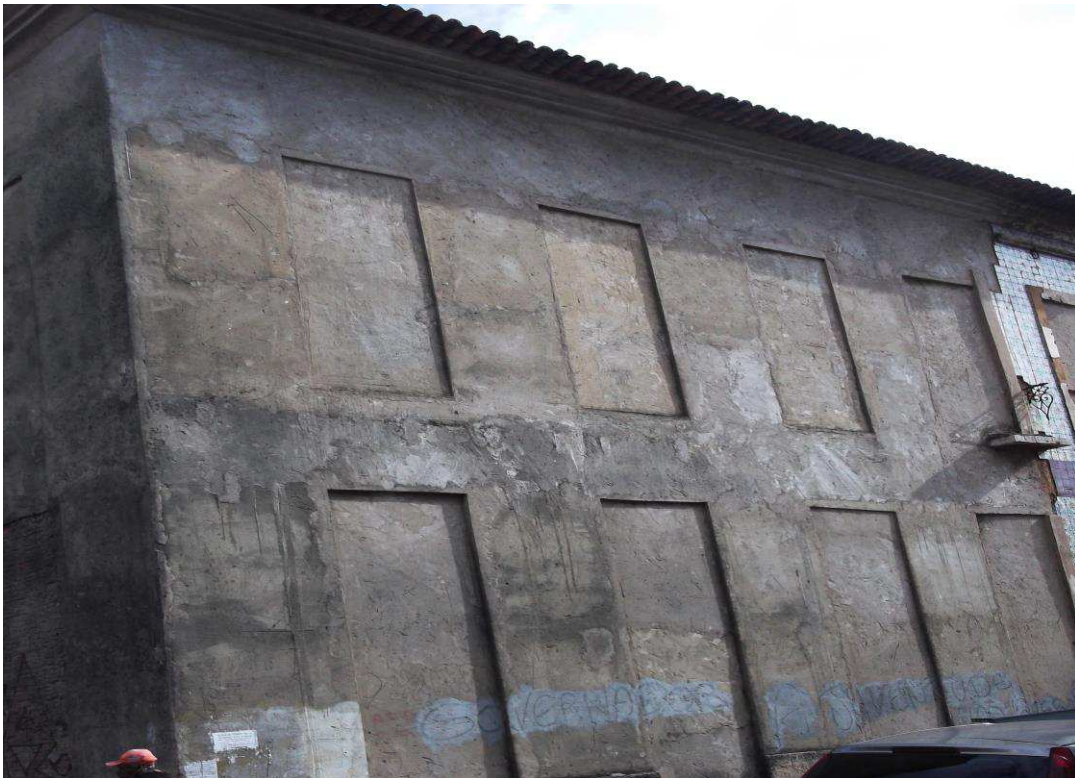
Fig. 65 Detalhe da fachada lateral da Rua Humberto de Campos
