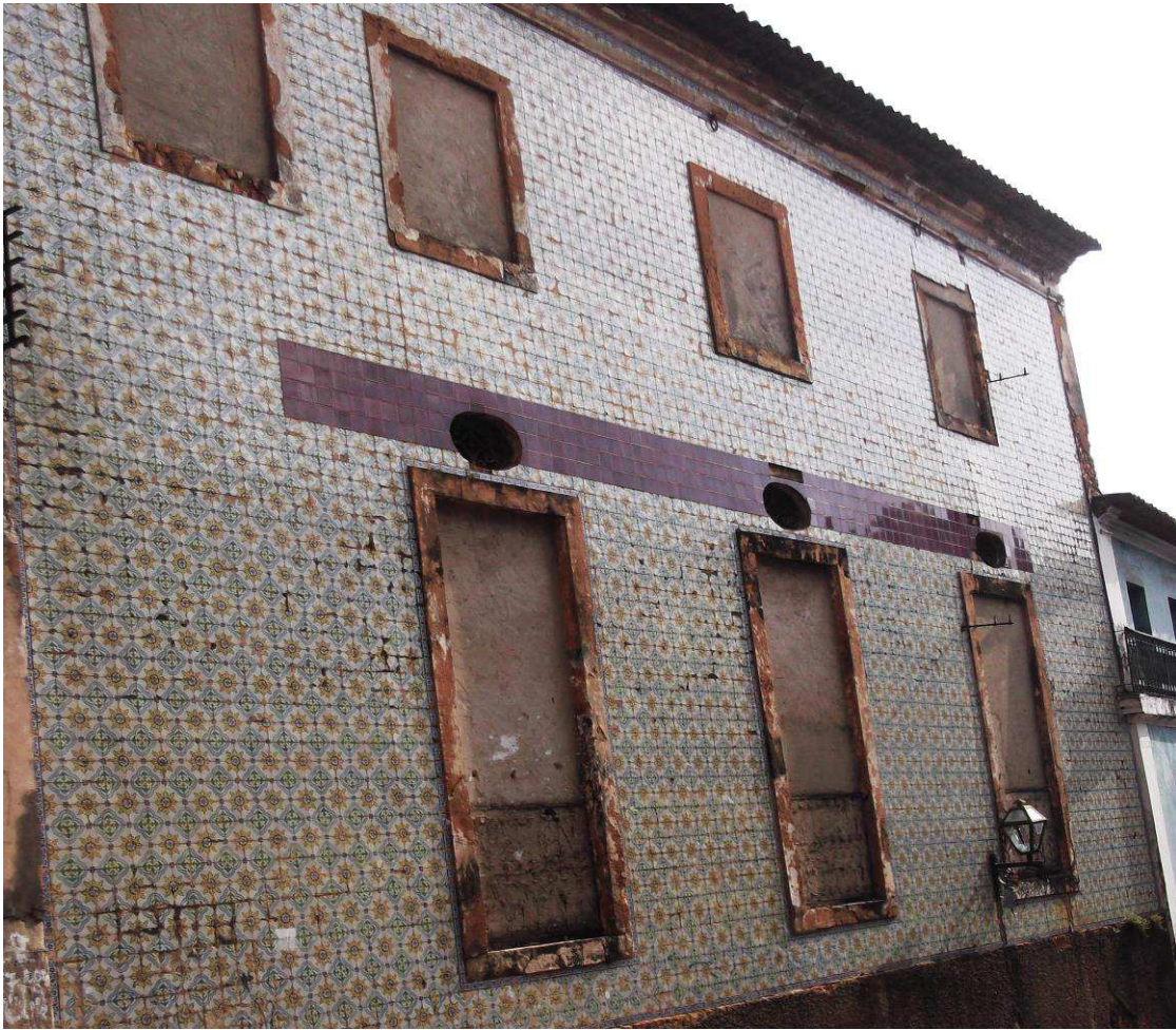
Fig. 66 Detalhe da fachada lateral onde ainda existem da Rua Humberto de Campos Fonte : Autora, 2013.
