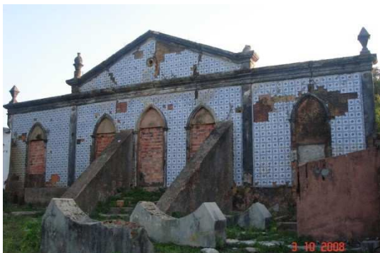
Figura 26 – Fachada. Fonte: Superintendência de Patrimônio Cultural, (Secma), 2008.
