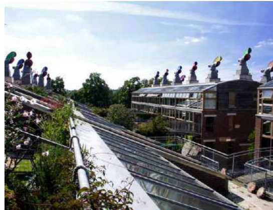
Foto 4 – Clarabóias, terraços e coberturas. Fonte: http://www.zedfactory.com
