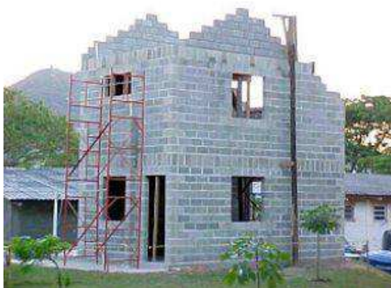
Figura 3.5.1 Obra em fase de construção com blocos feitos com casca de arroz. FONTE: HABITARE 2008.
