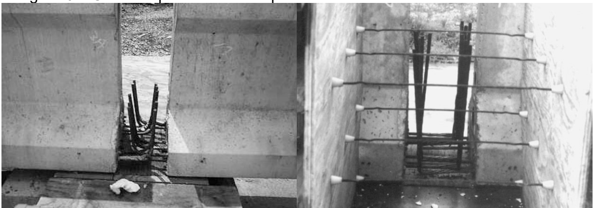
Figura 6 – Conexão para momentos positivos com barras e cordoalhas dobradas
