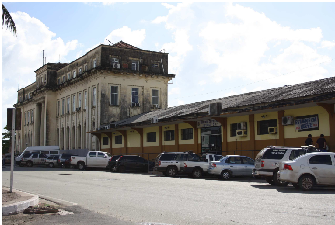
Figura 11: Vista geral do edifício e entrada da delegacia. Fonte: Arquivo pessoal.
