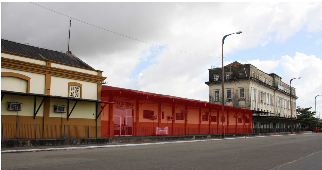
Figura 36: Prédio anexo a ser demolido. Fonte: Arquivo pessoal.
