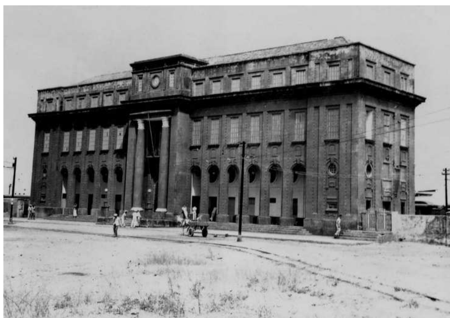
Figura 02: Estação João Pessoa Fonte: Tibor Jablonsky
