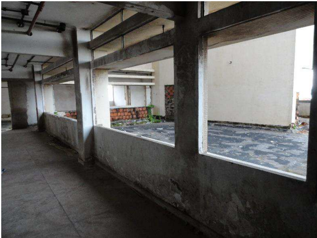
Figura 59 - Vista interna do corredor do quarto pavimento. Fonte: BATISTA, 2017.
