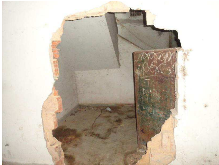
Figura 43- Registro de abertura feita em parede de alvenaria, no primeiro subsolo, atrás da caixa de escada secundária. Fonte: BATISTA, 2017.
