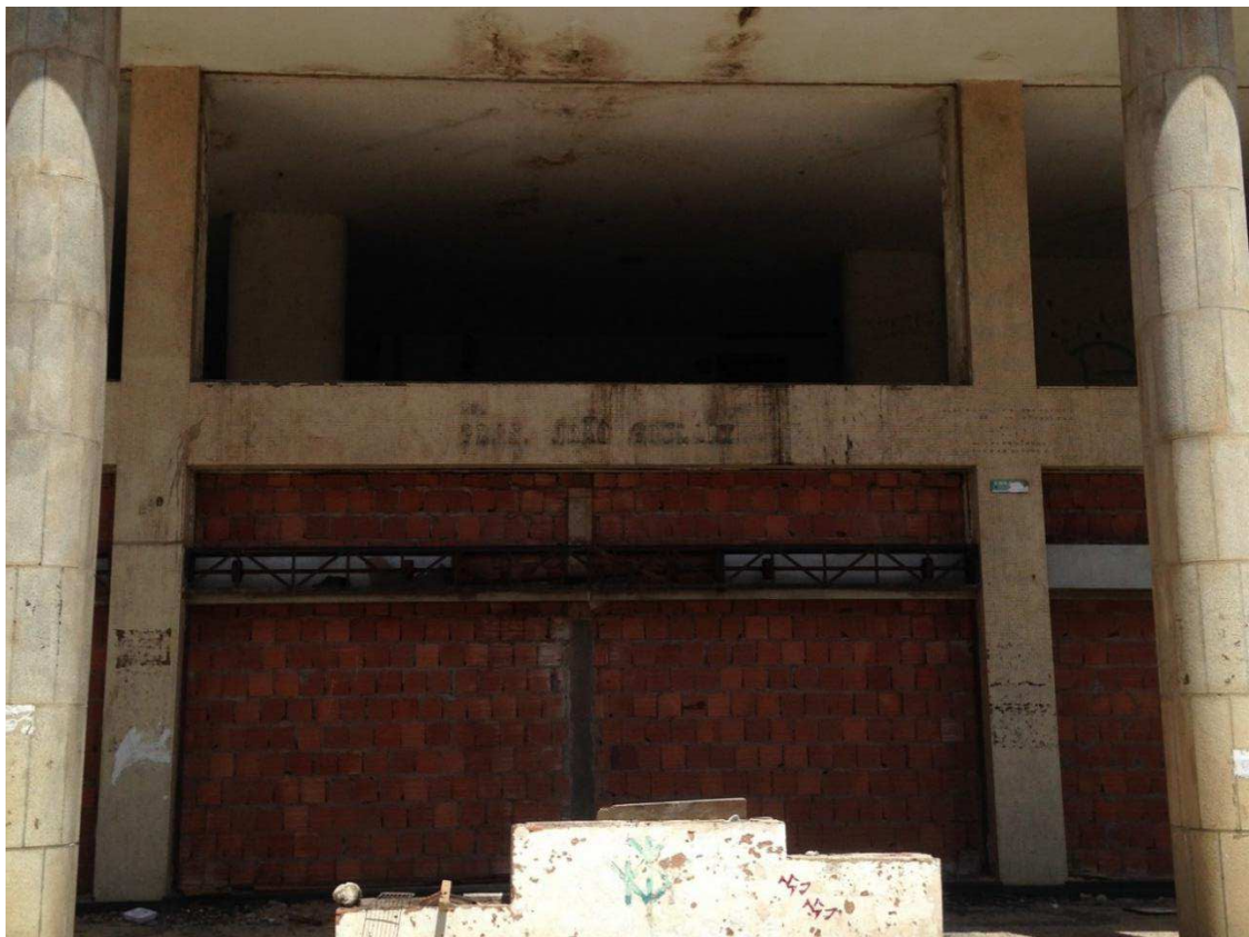
Figura 37 - Registro aproximado da fachada frontal do Ed. João Goulart, feito em julho. Fonte: BATISTA, 2017.
