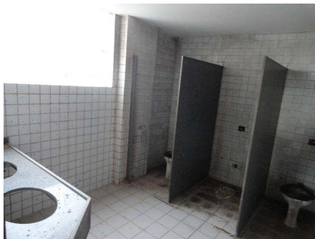
Figura 65 - Vista interna de um dos sanitários, em trecho entre quinto e décimo pavimento. Fonte: BATISTA, 2017.
