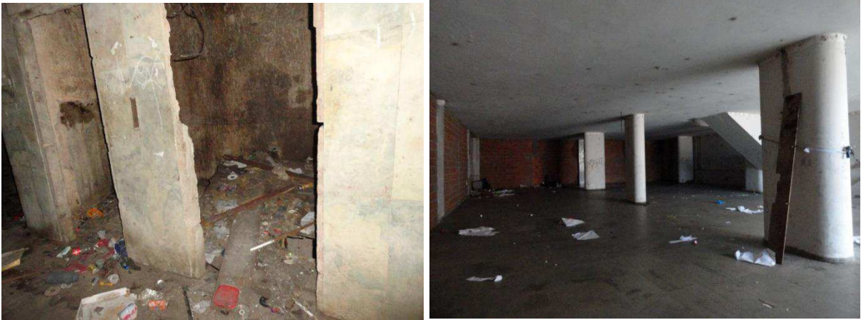
Figura 39- Vista interna do salão no térreo. Fonte: BATISTA, 2017.
