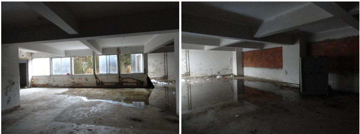
Figura 41 - Vista interna do primeiro subsolo, voltado para vãos de esquadrias ainda existentes. Fonte: BATISTA, 2017.
