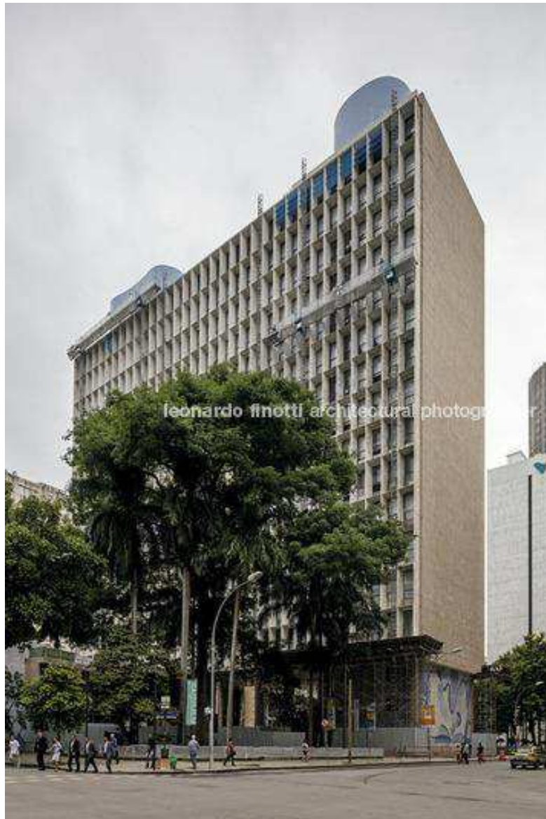
Figura 2 - Fachada do prédio do MEC. Fonte: Leonardo Finotti.
