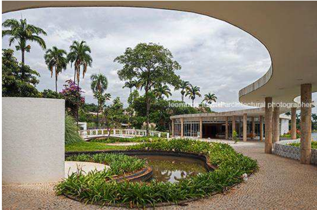
Figura 6 - Terraço do Iate Clube com detalhe para laje curvilínea. Fonte: Leonardo Finotti. Disponível em < www.leonardofinotti.com >
