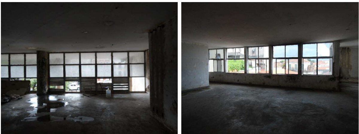
Figura 48 - Vista interna das esquadrias da fachada principal da sobreloja. Fonte: BATISTA, 2017.
