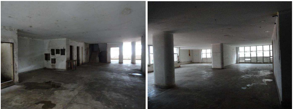
Figura 46 - Vista interna da sobreloja, voltada para acesso principal. Fonte: BATISTA, 2017.
