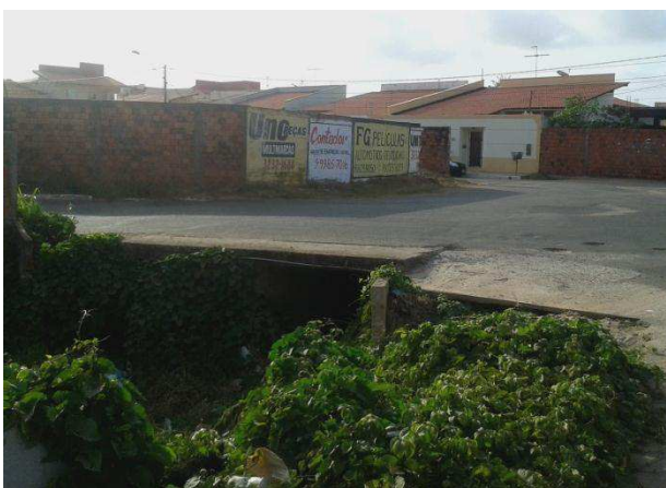
Figura 52 – Canalização sob sistema viário. Fonte: ARAUJO, 2015.
