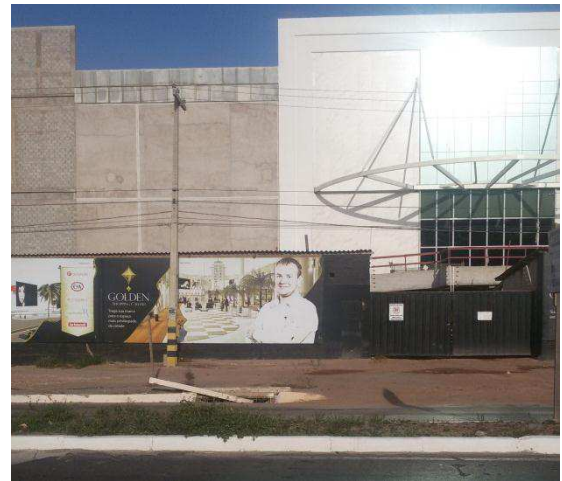
Figura 38 – Av. Avicência, evidenciando Shopping Golden Calhau em construção. Fonte: ARAUJO, 2015.
