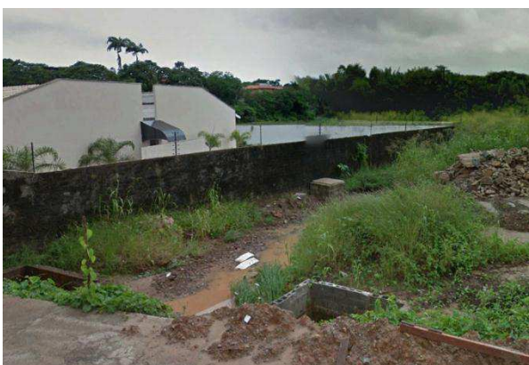
Figura 43 – Aterramento das margens do rio. Fonte: Google Street View, 2015.
