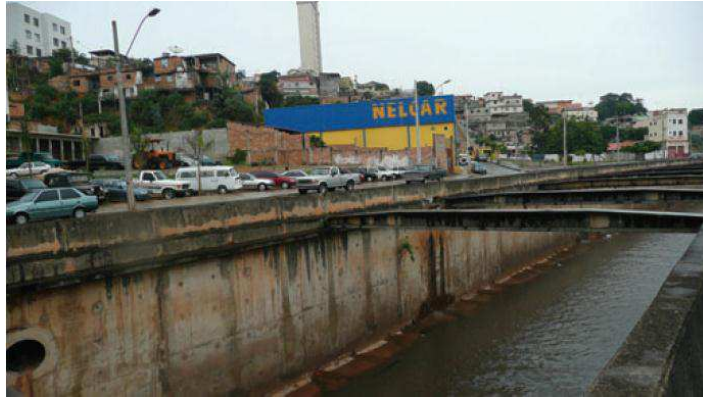
Figura 7 – Rio canalizado em Belo Horizonte.
