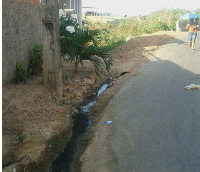
Figura 60 – Esgoto a céu aberto destinando-se para o Rio, em comunidade próximo ao Shopping do Automóvel
