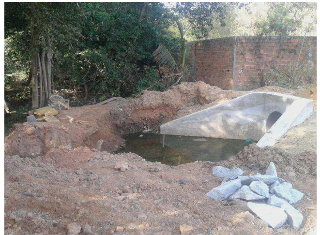
Figura 47 – Canalização desaguando no rio. Fonte: ARAUJO, 2015.
