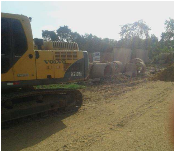
Figura 46 – Instalação de infraestrutura. Fonte: ARAUJO, 2015.
