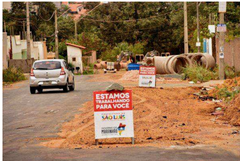
Figura 26 – Prefeitura de São Luís realizando obras de drenagem profunda na Rua Presidente Juscelino.
