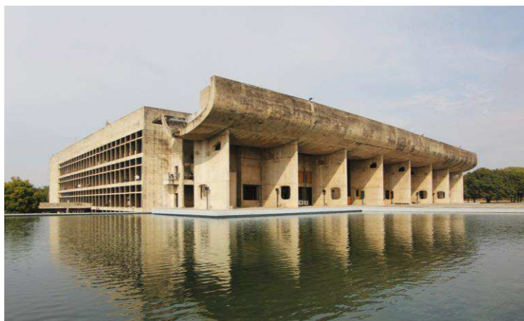
Figura 6. Palácio da Assembleia em Chandigarh
