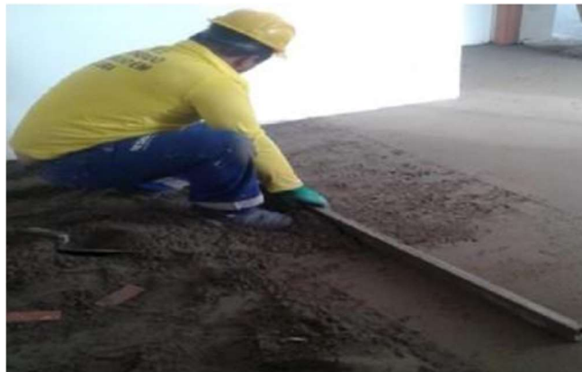
Figura 4- Preparo de base para contra-piso
