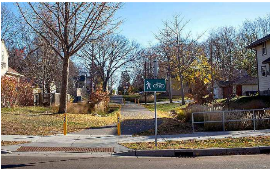
Ilustração 56 – Intervenção nas ruas adjacentes à Avenida 37.
