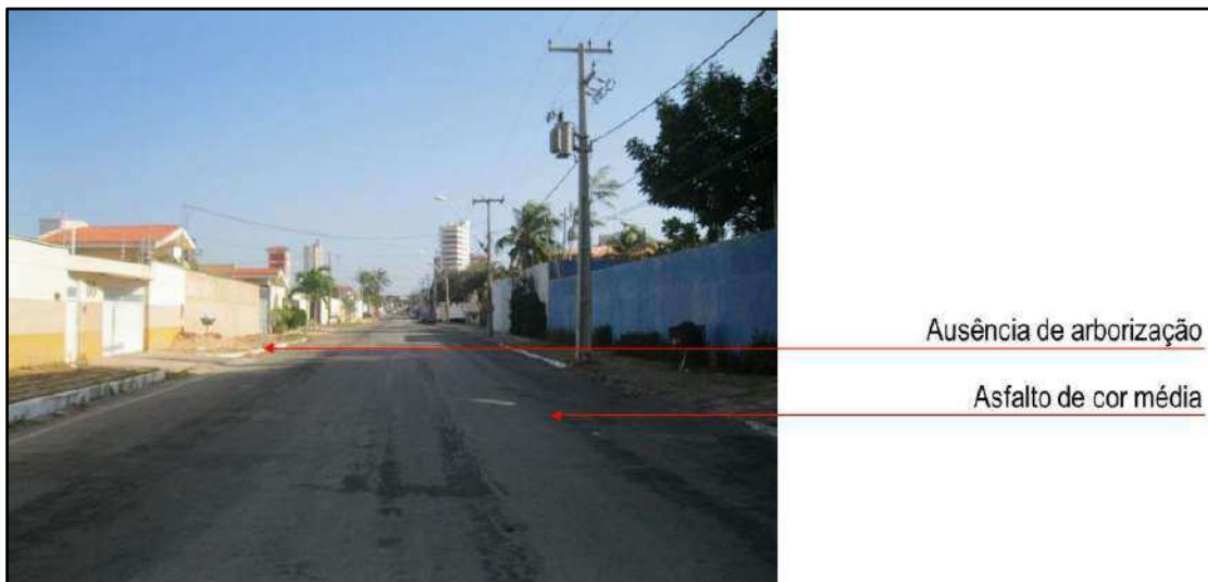
Ilustração 136 – Situação atual da Rua das Cegonhas.
