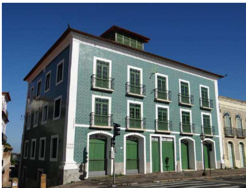
Figura 13: Solar dos Belfort - 2015
