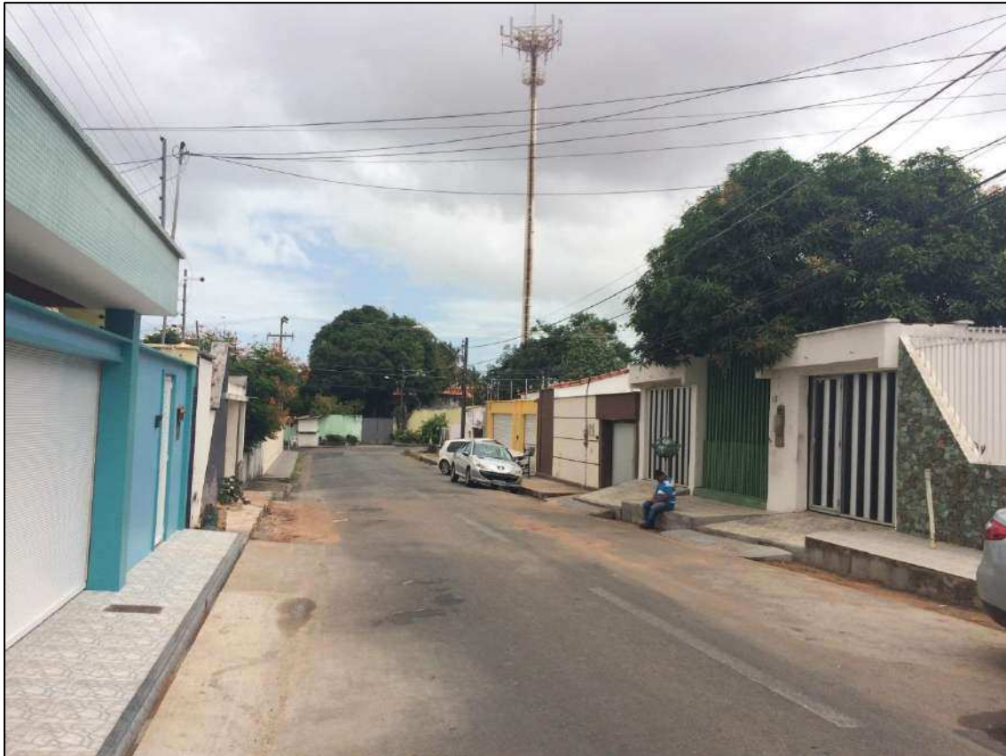
Figura 82 - Calçadas estreitas e descontínuas na rua 06
