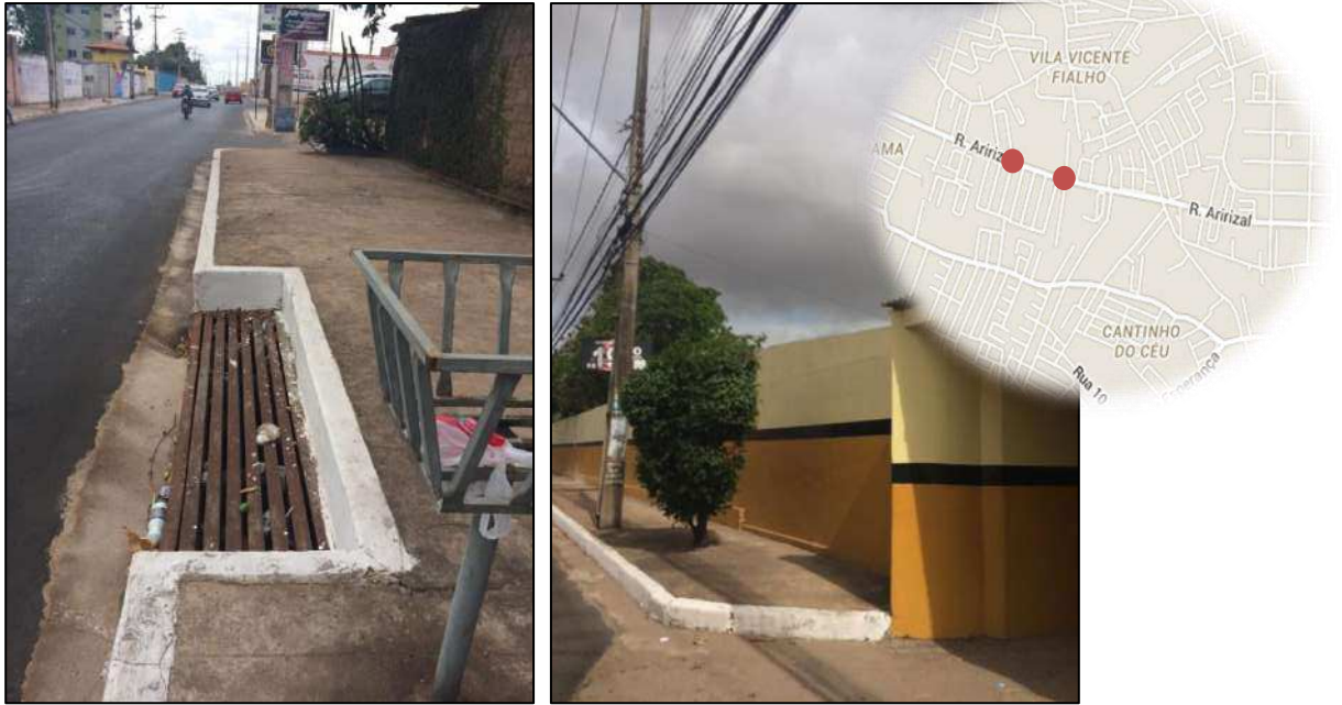
Figura 62 - Risco ao pedestre e ausência de vegetação adequada na rua do Aririzal
