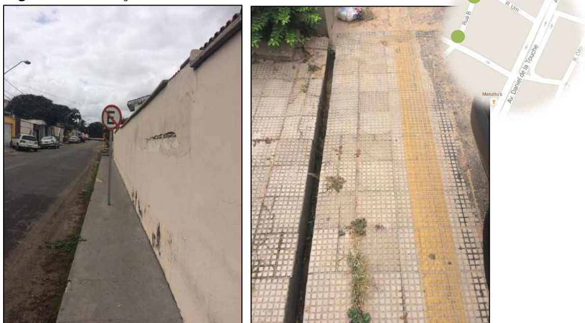
Figura 71 - Proibição de estacionamento na rua 06
