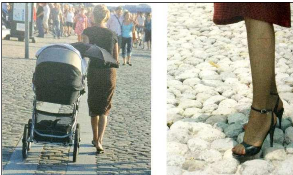
Figura 25 - Pavimentação inadequada nas calçadas
