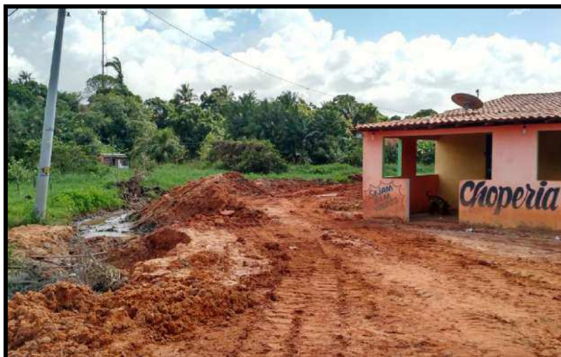
Figura 39 - Trecho do canal desviado
