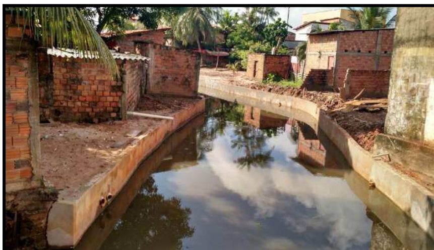
Figura 35 - Residências próximas ao canal
