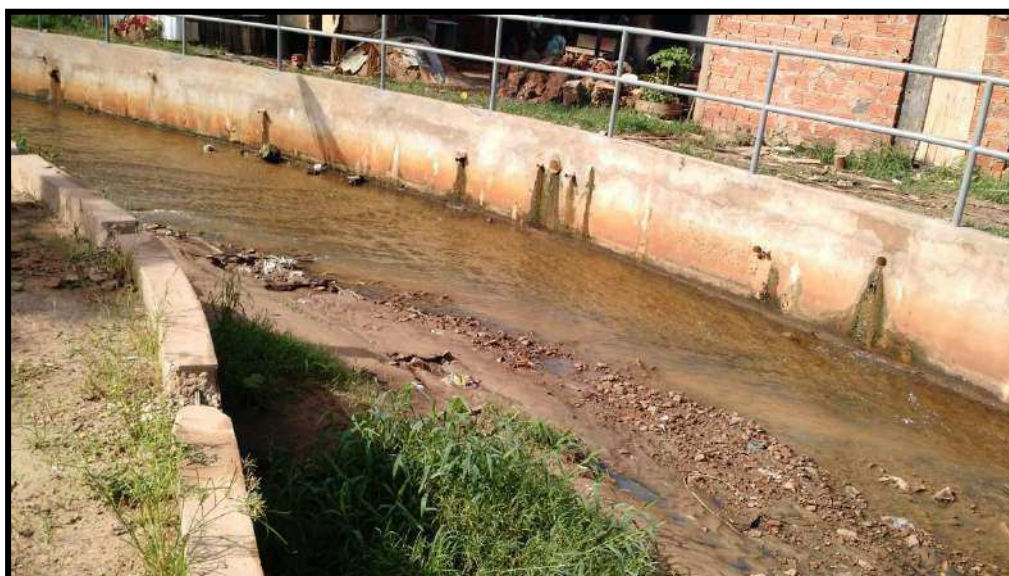
Figura 33 - Trecho do canal revestido em concreto armado
