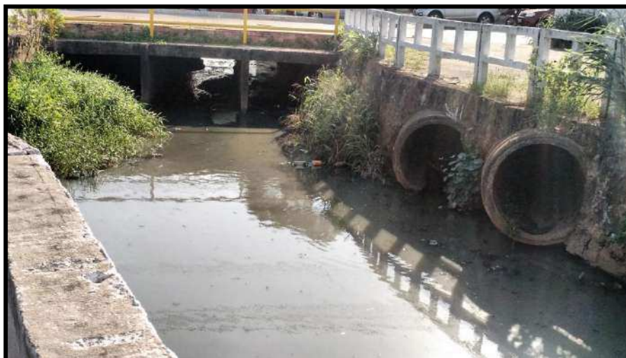
Figura 47 - Vegetação e dutos de drenagem no canal
