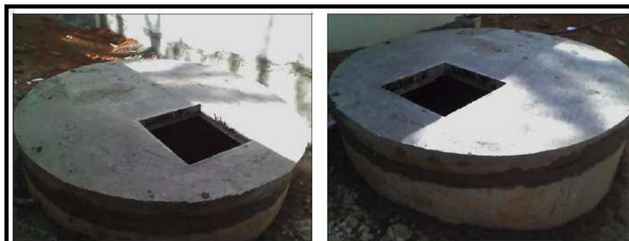
Figura 13- Microrreservatório de águas pluviais
