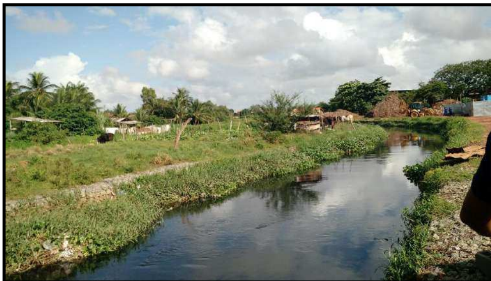
Figura 34 - Trecho do canal revestido com gabião
