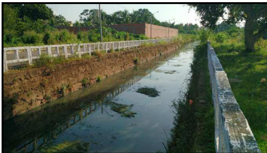
Figura 45 - Canal do Rio Gangan atualmente
