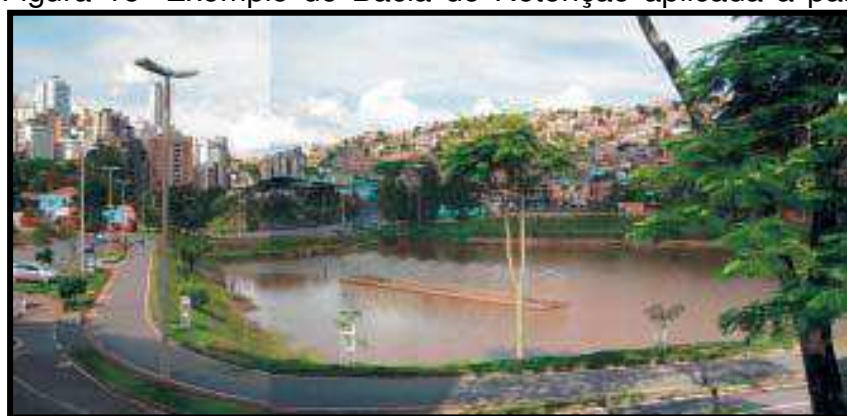
Figura 15- Exemplo de Bacia de Retenção aplicada à paisagem urbana
