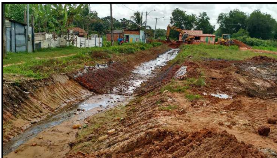
Figura 38 - Trecho com a colocação de gabião
