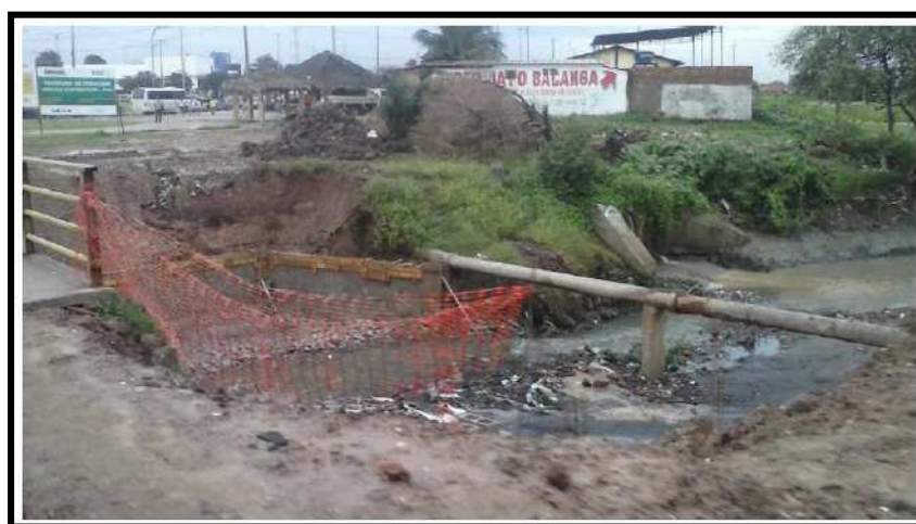
Figura 40 - Obras no canal em 2014
