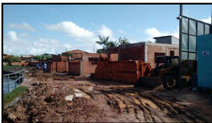
Figura 36 - Unidades habitacionais em construção
