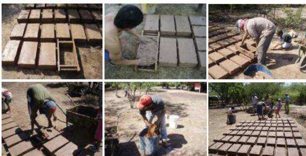
Figura 2 - Etapas de moldagem dos blocos de adobe
