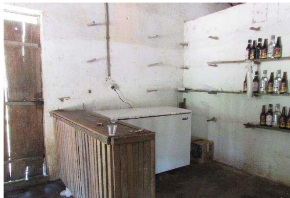
Figura 76 - Adobe revestido (Interno) - Casa Cesar - Povoado Lagoa Amarela, Chapadinha/MA
