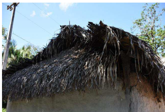
Figura 61 - Cobertura de palha - Casa Dagmar - Povoado Lagoa Amarela, Chapadinha/MA
