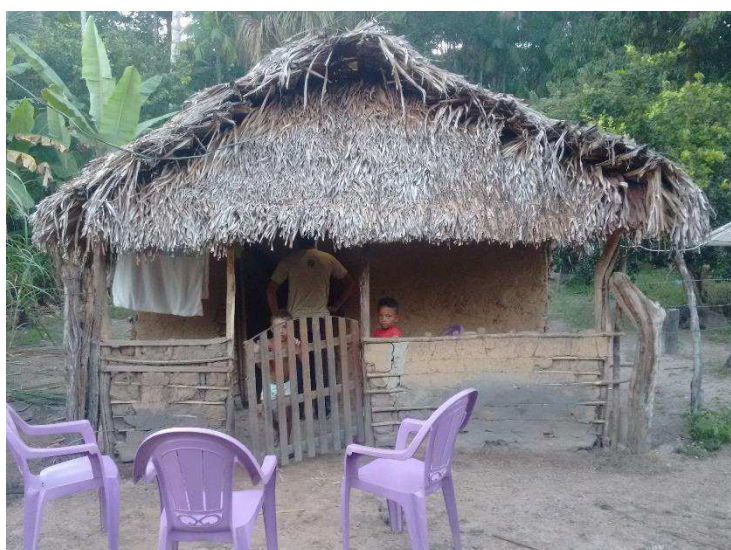
Figura 23 - Cobertura de palha - Casa Tatiane – Território Saco das Almas, Brejo/MA
