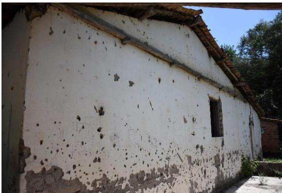
Figura 74 - Adobe revestido (Externo) - Casa Cesar - Povoado Lagoa Amarela, Chapadinha/MA
