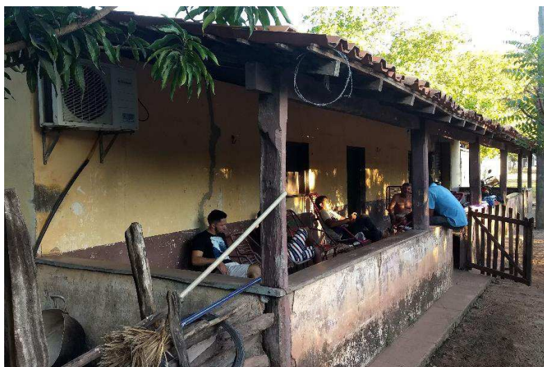
Figura 28 - Varanda - Casa Regina – Adobe revestido - Território Saco das Almas, Brejo/MA
