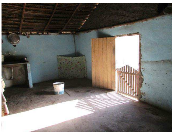
Figura 41 - Porta de madeira e piso cimentado - Casa Manoel - Território Saco das Almas, Brejo/MA
