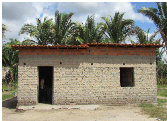
Figura 38 – Casa de Adobe Fachada principal não revestida – Casa Alexandra Território Saco das Almas, Brejo/MA
