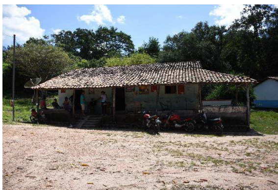
Figura 60 – Cob. telha cerâmica - Casa Cesar - Povoado Lagoa Amarela, Chapadinha/MA
