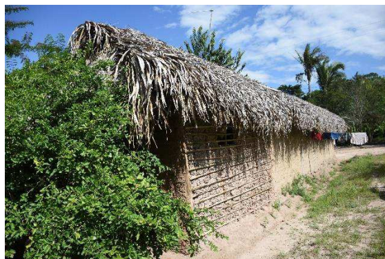
Figura 51 - Casa Roseane - Taipa - Povoado Barro Vermelho, Chapadinha/MA
