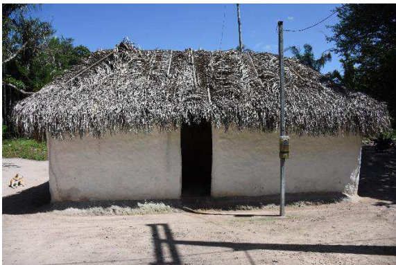
Figura 73 - Taipa revestida (externo) - Casa Dagmar - Povoado Lagoa Amarela, Chapadinha/MA
