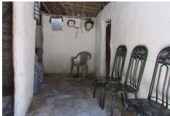
Figura 75 - Taipa revestida (Interno) - Casa Dagmar - Povoado Lagoa Amarela, Chapadinha/MA
