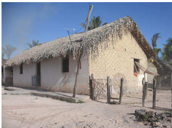
Figura 37 – Casa de Adobe Fachada principal revestida - Casa Manoel - Território Saco das Almas, Brejo/MA
