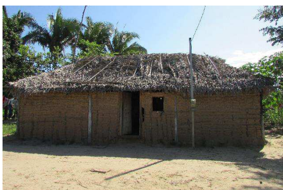
Figura 49 - Casa Ildene - Taipa - Povoado Barro Vermelho, Chapadinha/MA
