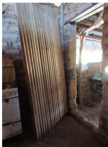
Figura 42 - "Porta" de madeira encostada - Casa Maria - Território Saco das Almas, Chapadinha/MA
