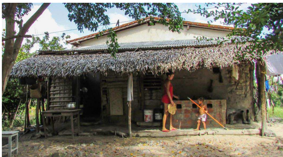
Figura 24 - Cobertura Telhas cerâmica, fibrocimento/palha - Casa Almeida - Território Saco das Almas, Brejo/MA.
