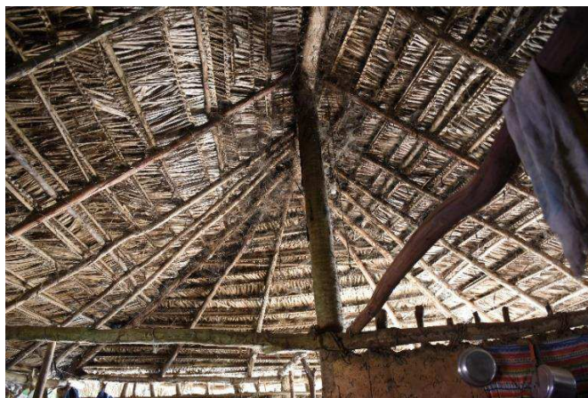
Figura 62 - Ponto de sustentação da cobertura - Casa Ildene - Povoado Barro Vermelho, Chapadinha/MA
