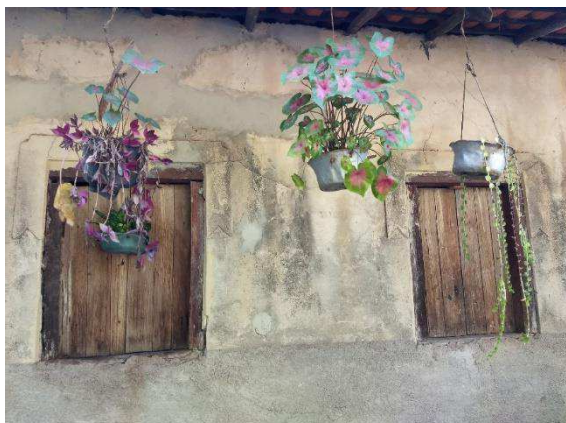
Figura 39 – Janelas de madeira - Casa Francisco - Casa de Adobe - Território Saco das Almas, Brejo/MA
