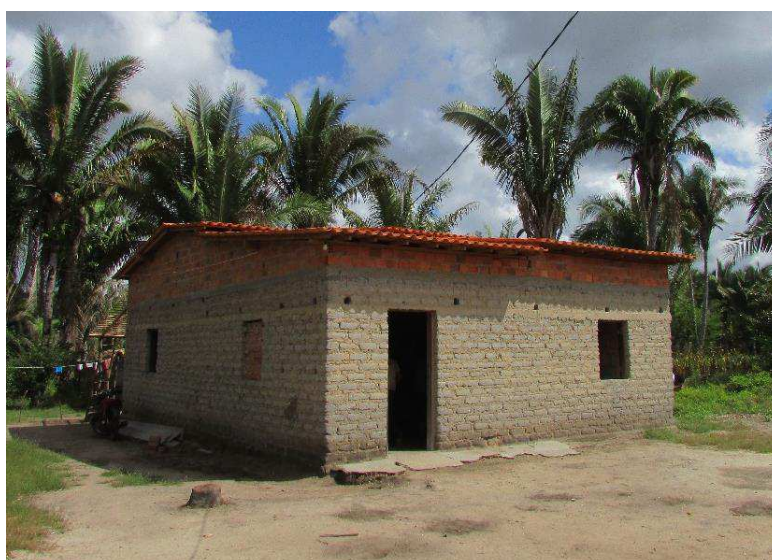
Figura 26 - Casa Alexandra – Adobe e Tijolo Cerâmico - Território Saco das Almas, Brejo/MA
