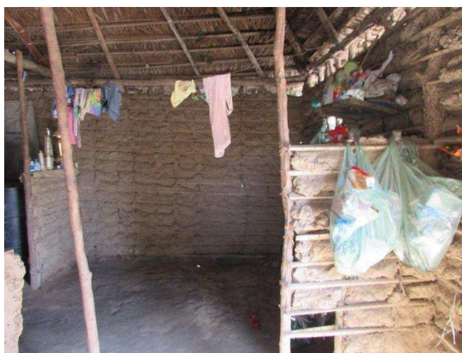
Figura 63 - Sustentação secundária - Casa Ildene - Povoado Barro Vermelho, Chapadinha/MA
