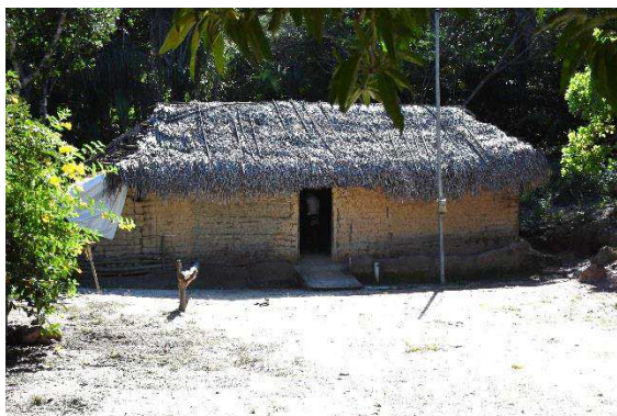
Figura 53 - Casa Clavildo - Taipa - Povoado Lagoa Amarela, Chapadinha/MA
