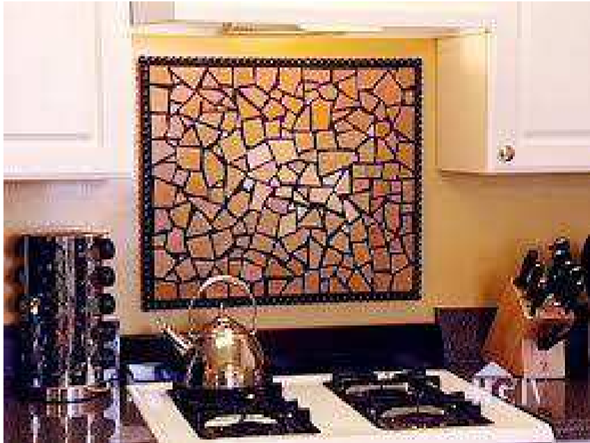
Figura 11 – Demonstração de reutilização de sobra de pisos avariados para compor painel de proteção da parede na cozinha.
