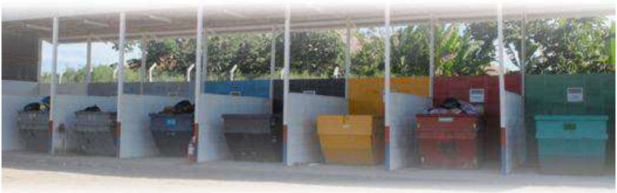
Figura 06 – Acondicionamento de RSCC em caçambas estacionárias e toneis.
