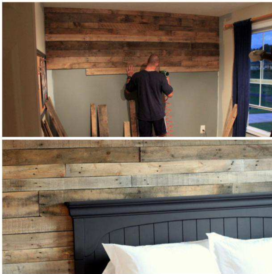
Figura 10 – Demonstração de reuso de Madeira de Demolição.
