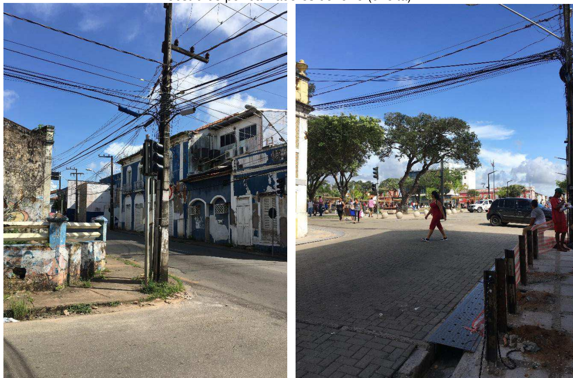
Figura 41 Presença de semáforos voltados apenas para via de circulação de automóveis em cruzamento com a Rua Jansen Miller (esquerda). Figura 42 Presença de travessia elevada sem demarcação de faixa para pedestres no cruzamento da Rio Branco com Av. Silva Maia, porém é possível perceber que em um dos lados o acesso é obstruído por balizadores de ferro (direita).
