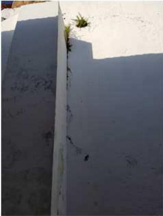
Figura 82: Fissuras no muro posterior do prédio Morada das Artes.
