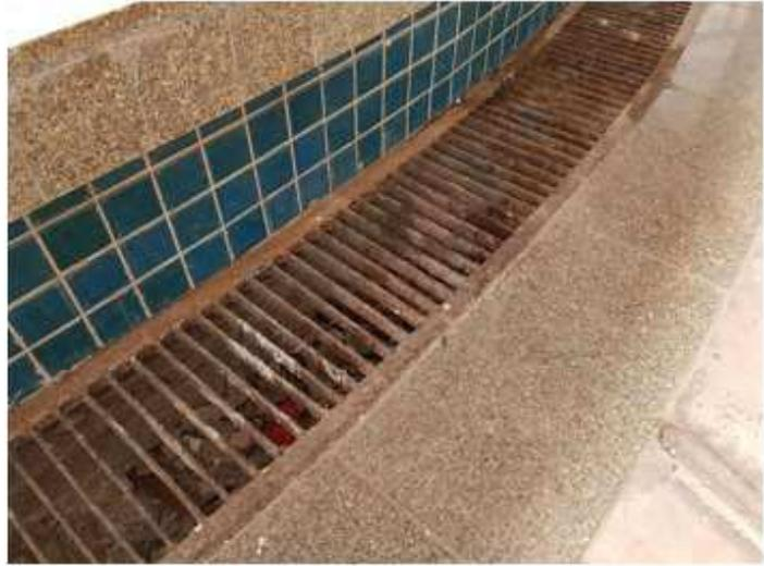
Figura 91: Detalhe da grelha de drenagem próxima ao espelho d'água onde nota-se sujeiras.
