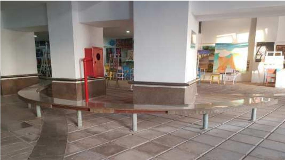
Figura 94: Banco do salão de exposições com partes faltantes em seu acabamento.
