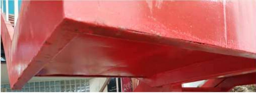
Figura 86: Detalhe dos pontos de oxidação em umas das escadas do prédio Morada das Artes. (Referente a figura 84)
