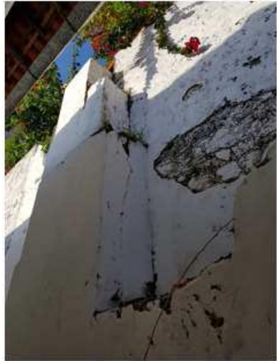
Figura 83: Fissuras e exposição da estrutura de pedra do muro posterior do prédio Morada das Artes.
