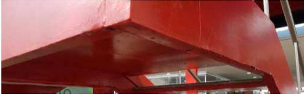
Figura 87: Detalhe dos pontos de oxidação em umas das escadas do prédio Morada das Artes. (Referente a figura 85)
