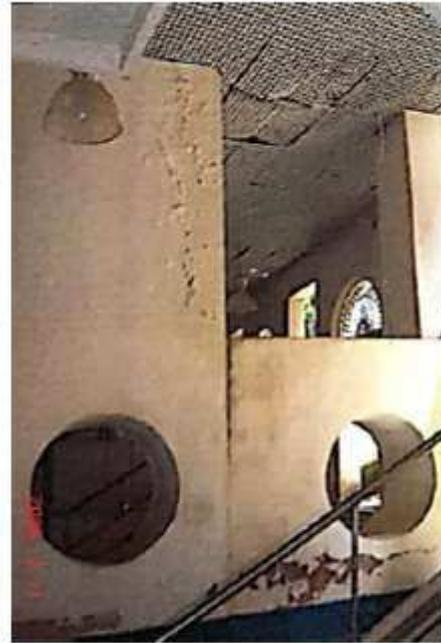
Figura 48: Forro e paredes danificadas no prédio Morada das Artes.
