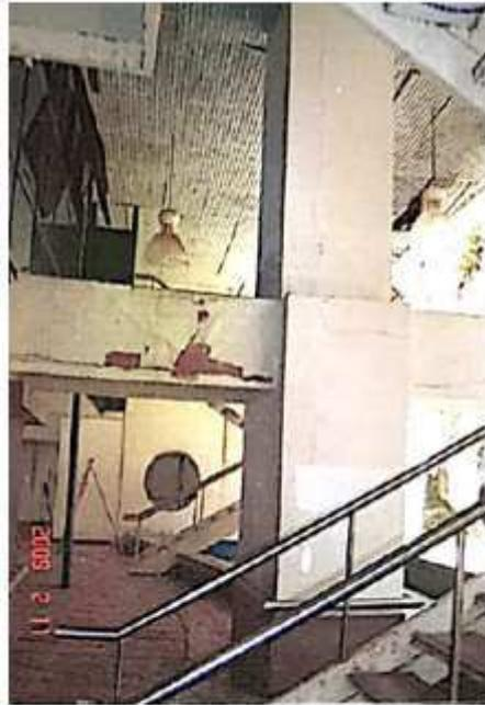
Figura 47: Viga trincada próximo ao espelho d'água no prédio Morada das Artes.
