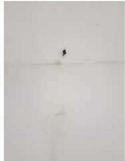
Figura 138: Dano ao forro ocasionado pela goteira na unidade nº 6.
