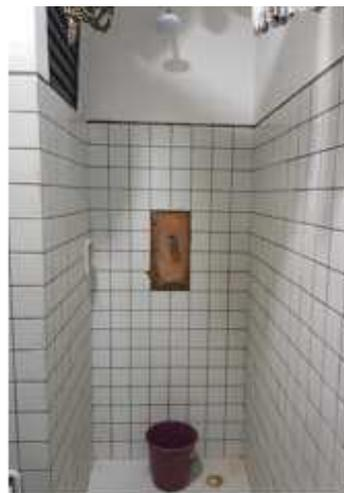
Figura 140: Revestimento danificado no banheiro da unidade nº2.
