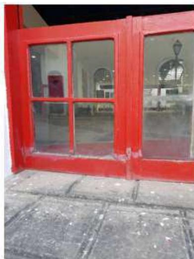
Figura 103: Detalhe do dano da porta da Figura 102.
