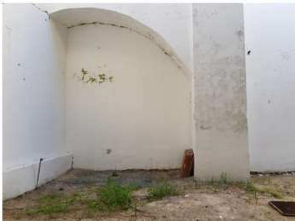
Figura 80: Deterioração por agentes biológicos no muro posterior do prédio Morada das Artes.
