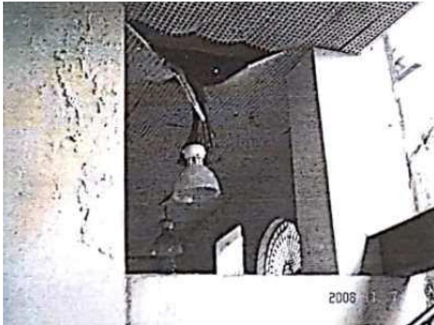
Figura 45: Desmoronamento do forro do prédio Morada das Artes.
