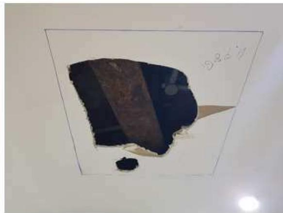
Figura 106: Detalhe do forro em gesso aberto para inspeção do vazamento.
