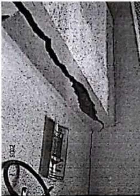
Figura 43: Trinca profunda em viga do prédio Morada das Artes
