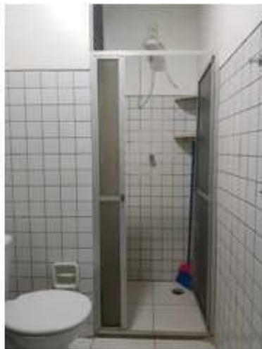
Figura 123: Box em acrílico da unidade nº 6 e chuveiro elétrico.
