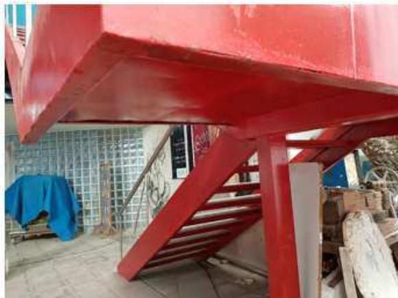
Figura 84: Pontos de oxidação em uma das escadas.
