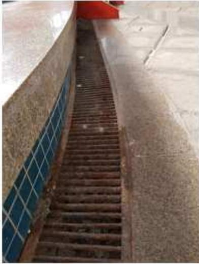
Figura 90: Grelha de drenagem oxidada próxima ao espelho d'água.
