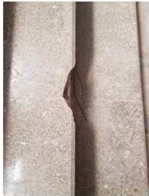
Figura 93: Detalhe do granito danificado.
