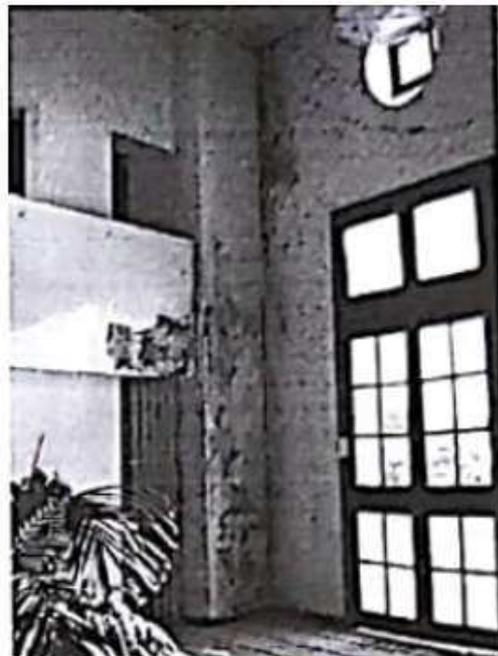
Figura 44: Infiltração no prédio Morada das Artes
