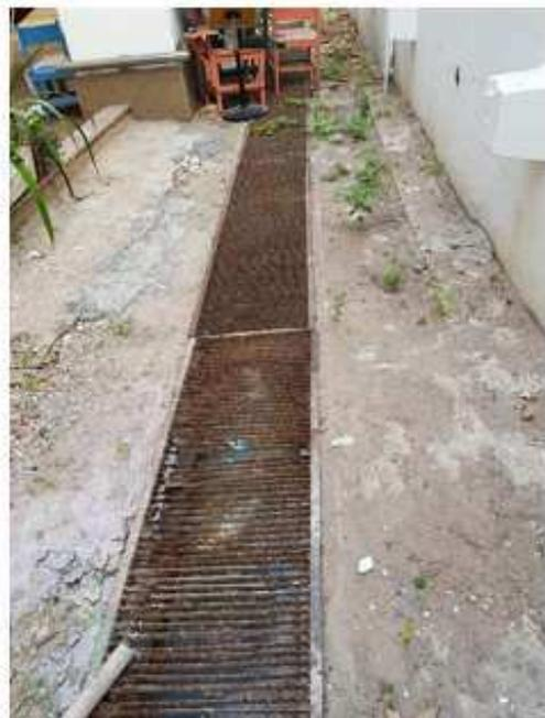
Figura 89: Uma das grelhas de drenagem da área livre do prédio Morada das Artes.
