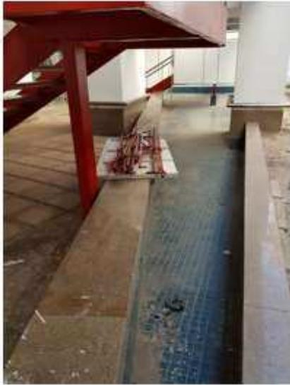
Figura 96: Detalhe do acúmulo de sujeira no espelho d'água.
