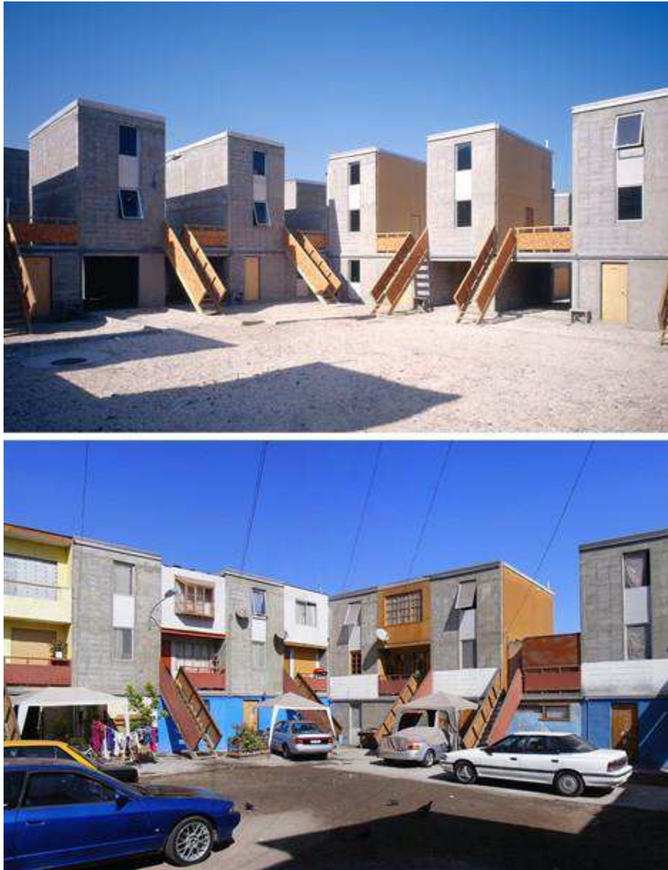
Figura 18 - As obras concluídas e as intervenções posteriores dos moradores. Fonte: Tory-Henderson, 2016.
