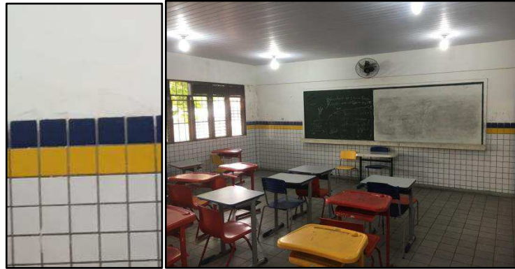
Figura 48 - Padronização dos revestimentos nos ambientes internos
