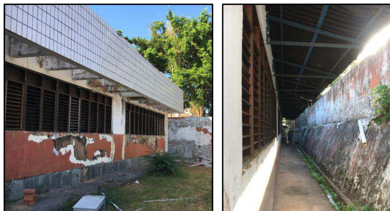
Figura 30 (à esquerda) - Elemento controlador da incidência direta de luz nas salas de aula voltadas para a entrada; Figura 31 (à direita)- Elemento controlador da incidência direta de luz nas salas de aula voltadas para o fundo.
