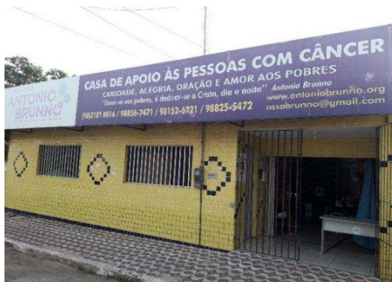
Figura 1: Fachada da Casa de Apoio FAB
