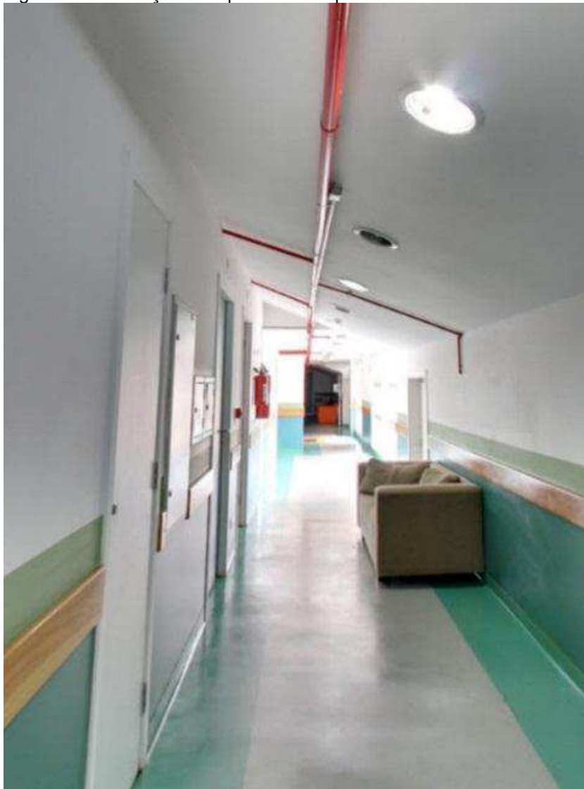
Figura 14: Circulação com piso vinílico//portas em fórmica
