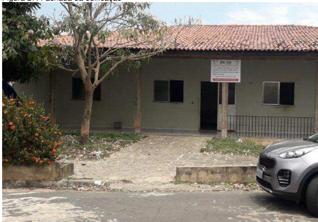
Figura 27: Fachada da edificação
