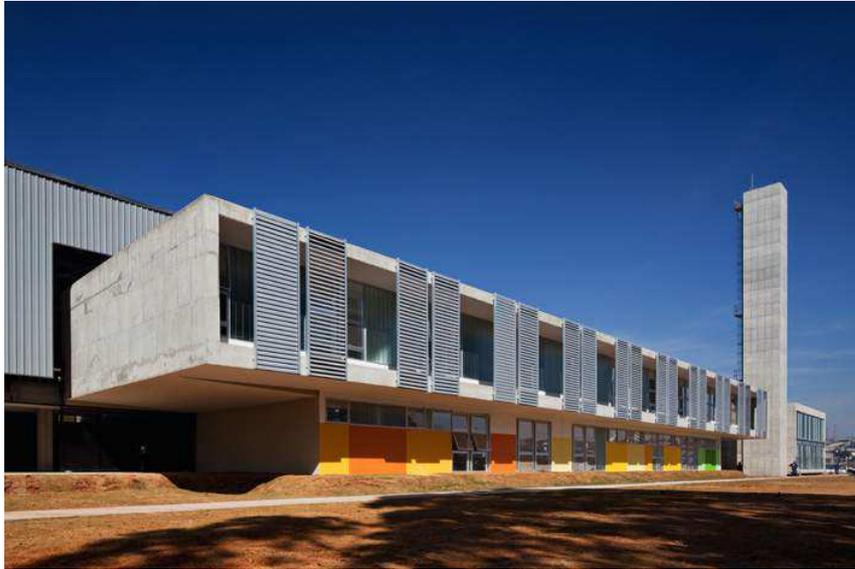
**Figura 42 - Blocos de concreto e janelas protegidas por brises**
