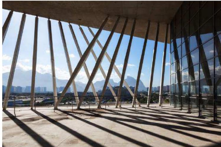
**Figura 28 - Brises Soleil para proteção do sol**
