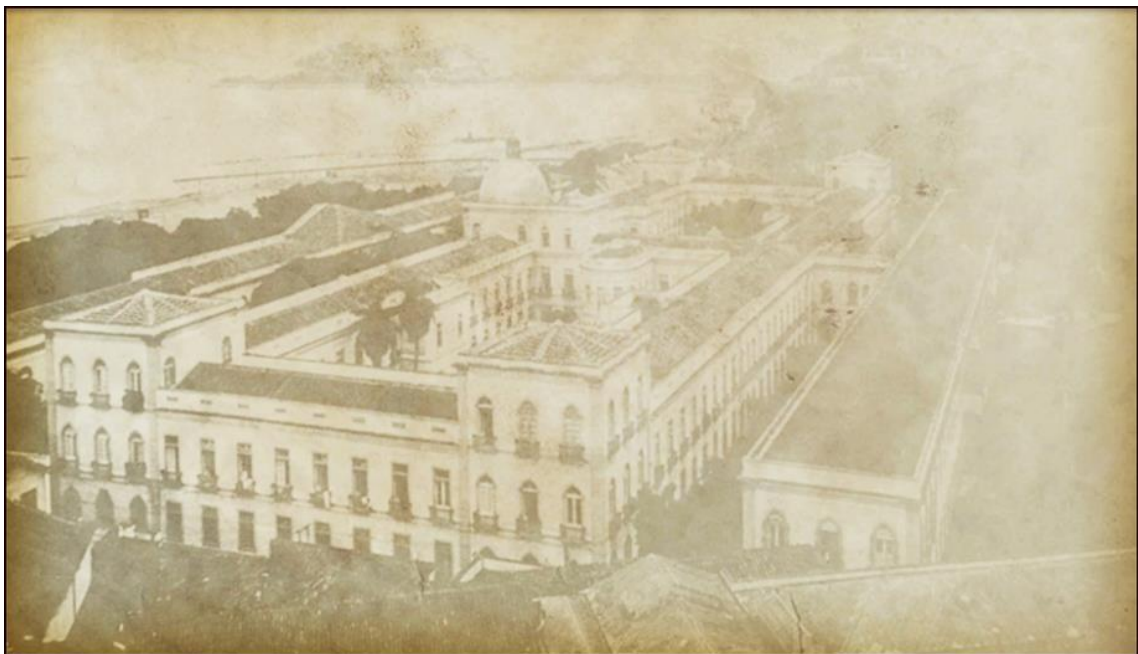
Figura 10 – Fachada do Hospício Pedro II
