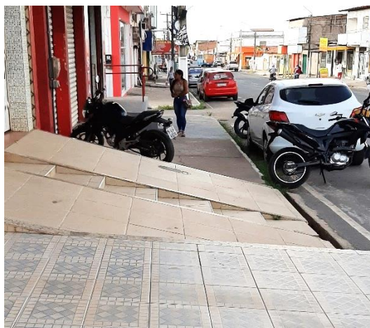
Figura 17 - Rampas para acesso de veículos ao lote, invadindo a faixa de livre circulação nas calçadas
