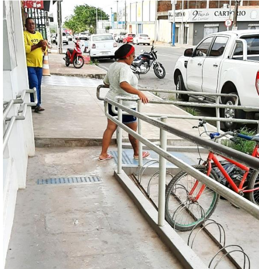
Figura 24 - Rampa interrompendo a continuidade da calçada
