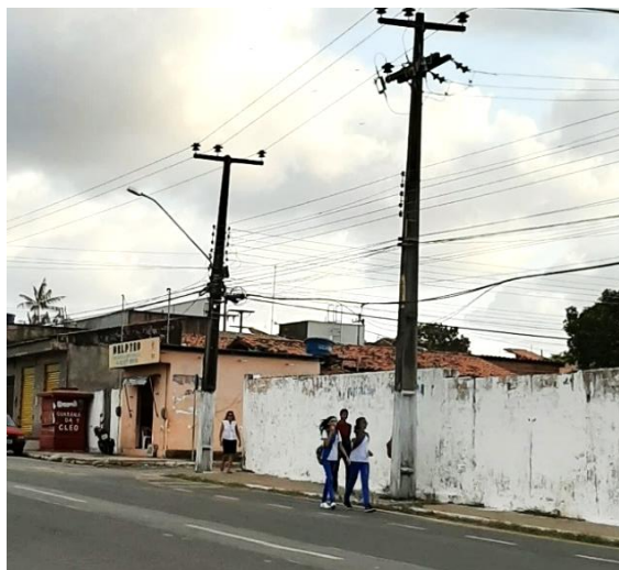
Figura 21 - Pessoas recorrendo a pista de rolamento devido a obstáculos
