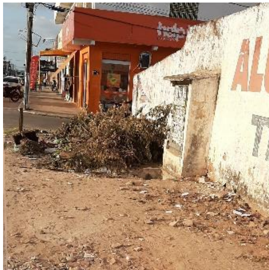
Figura 31 - Lixo bloqueando passagem de circulação
