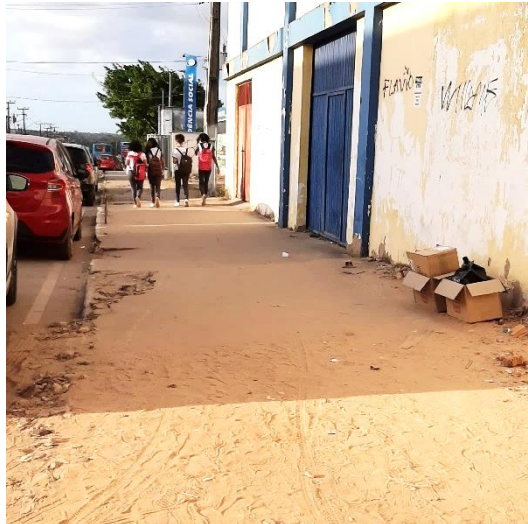
Foto 18 - Calçada com pavimentação desgastada
