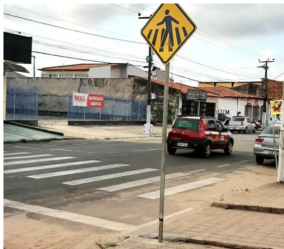
Figura 37 - Pontos com sinalização vertical e horizontal
