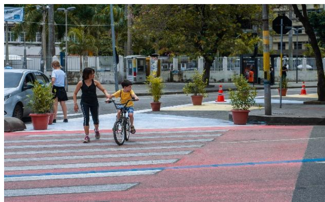
Figura 3 - Sinalização horizontal e alargamento das calçadas
