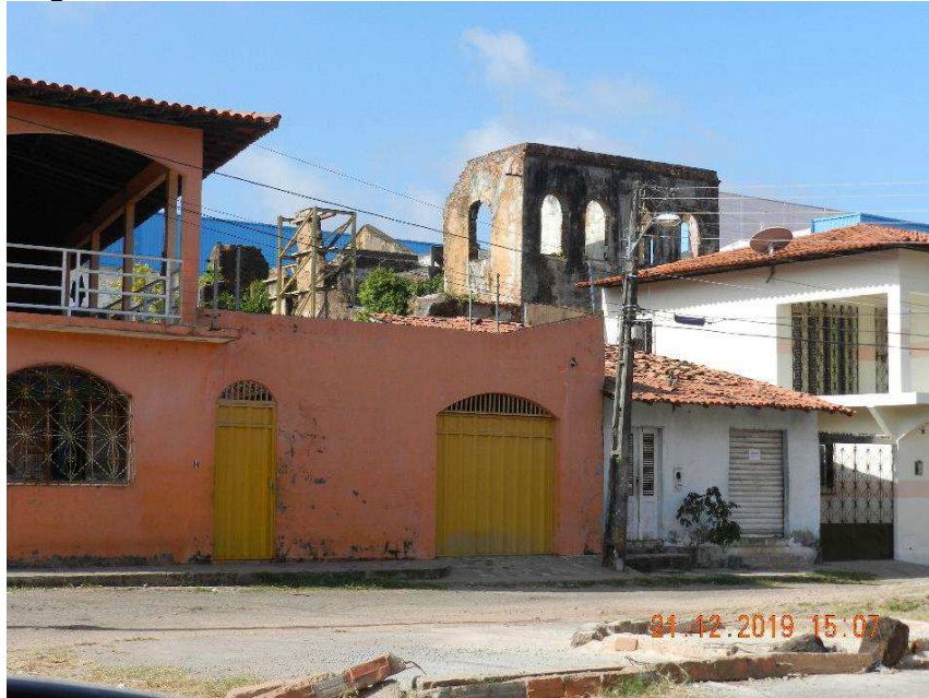
Figura 49 – Ruínas do Casarão 3 ao fundo das residências
