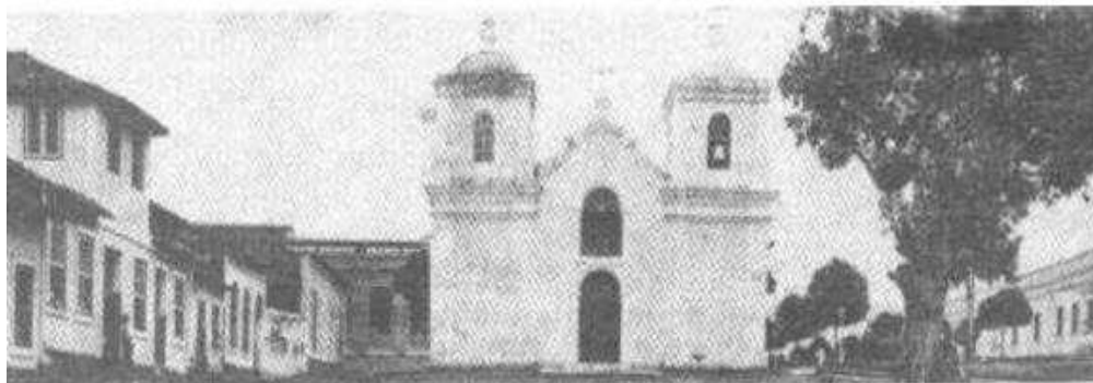
Figura 4 – Igreja de Santaninha e seu largo. A esquerda residências recuadas e à direita, o Quartel.
