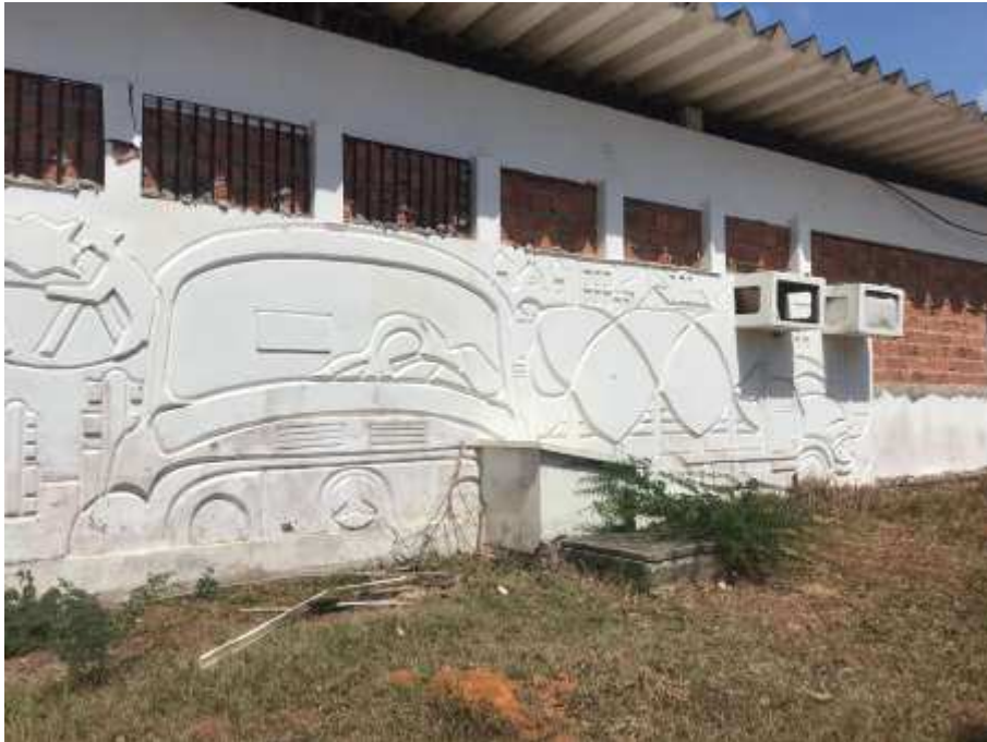
Figura 49 - PAINEL DA ANTIGA MARDISA EM ESTADO DE ABANDONO
