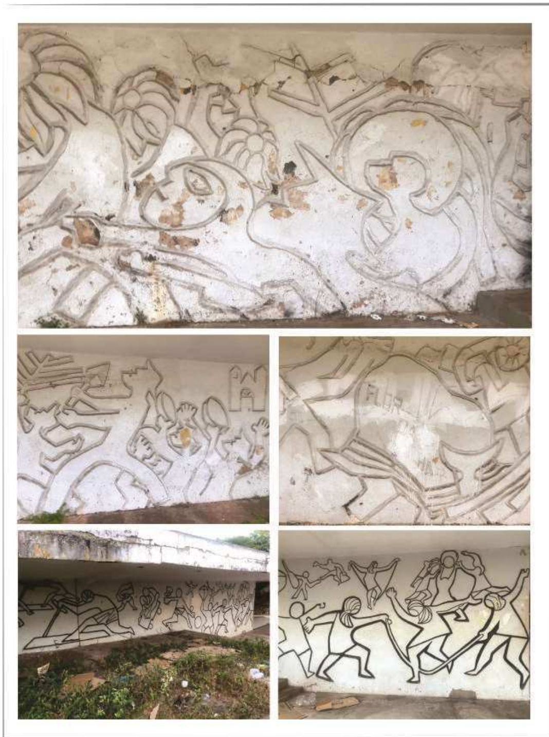
Figura 53 - Montagem dos painéis de Almeida para o Parque do Bom Menino
