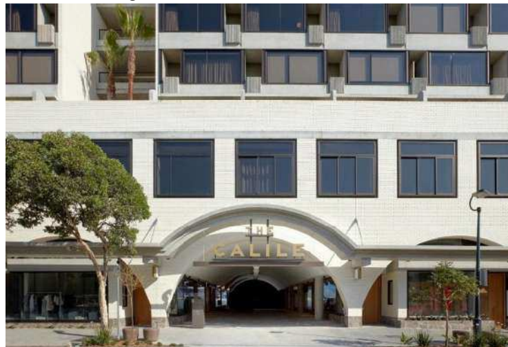
Figura 26. Fachada Frontal Calile Hotel
