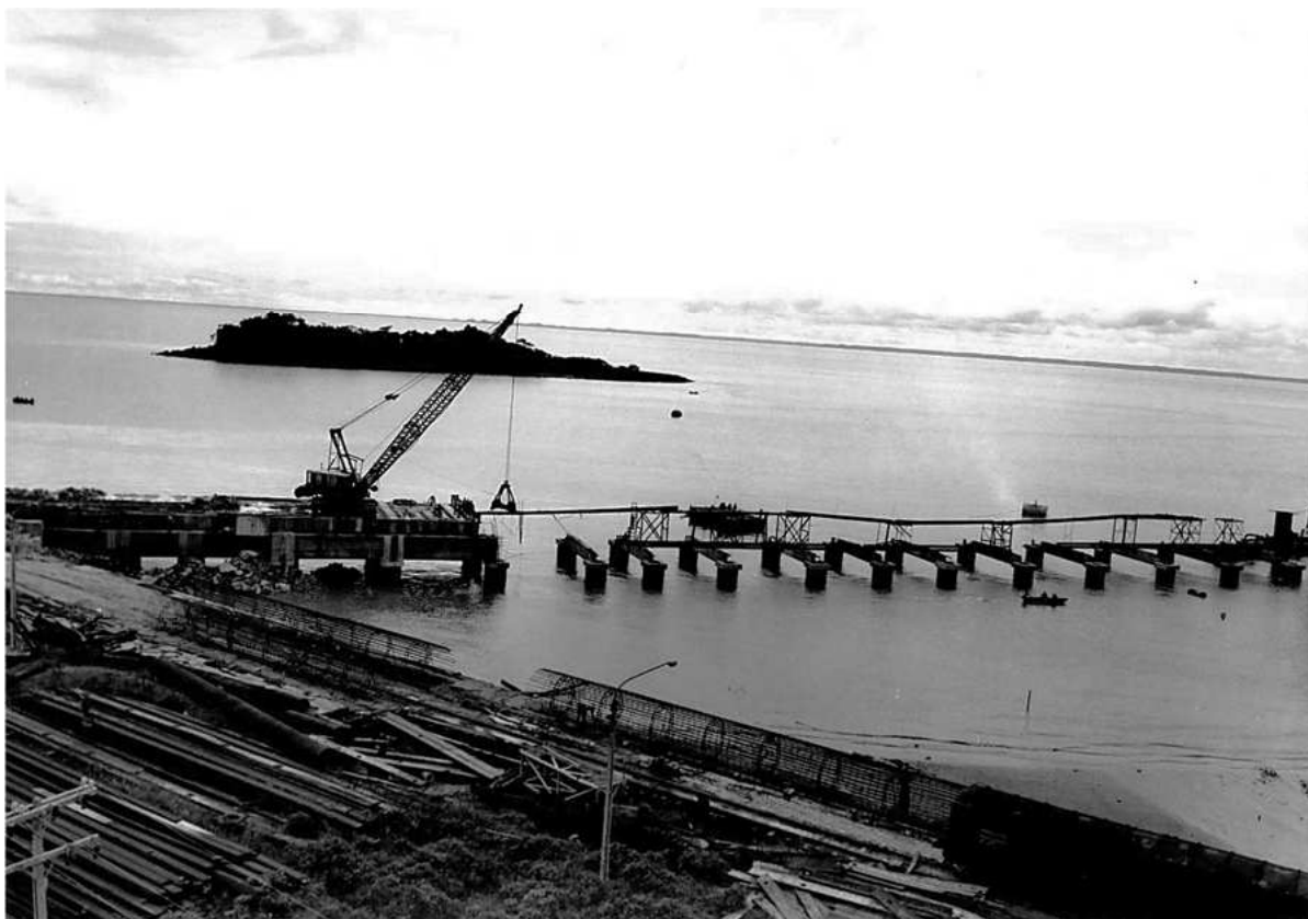
Figura 45 - Registro da construção de berço no Porto do Itaqui, em 1974.
