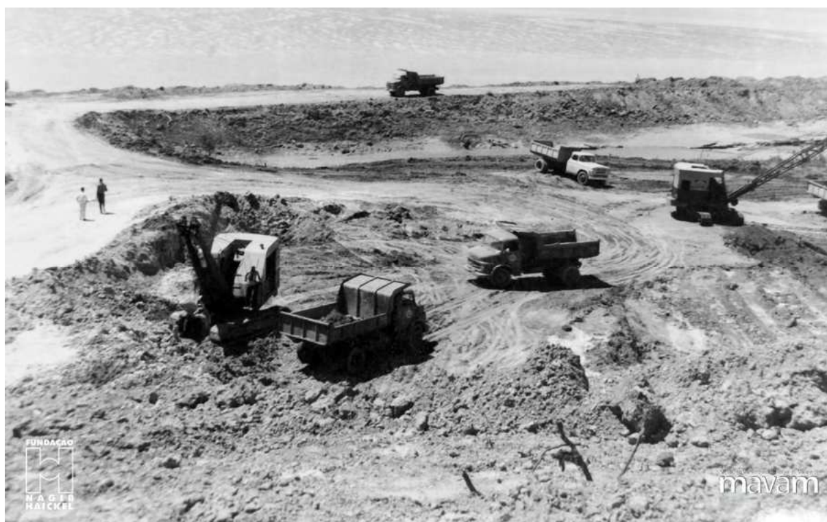
Figura 43 - Obras de construção da Barragem do Bacanga, 1969.
