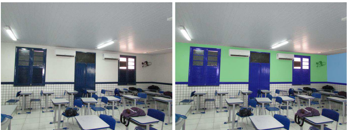
Figura 34 - Antes e depois: vista da parede oposta à porta de entrada da sala
