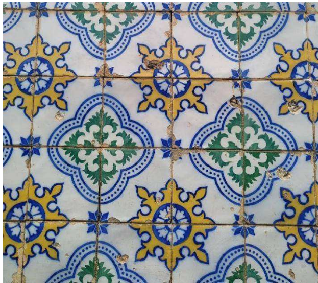
Figura 22. Detalhe dos azulejos na fachada.
