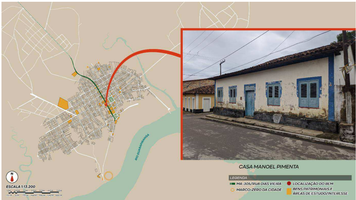
Figura 49. Localização da Casa Manoel Pimenta.
