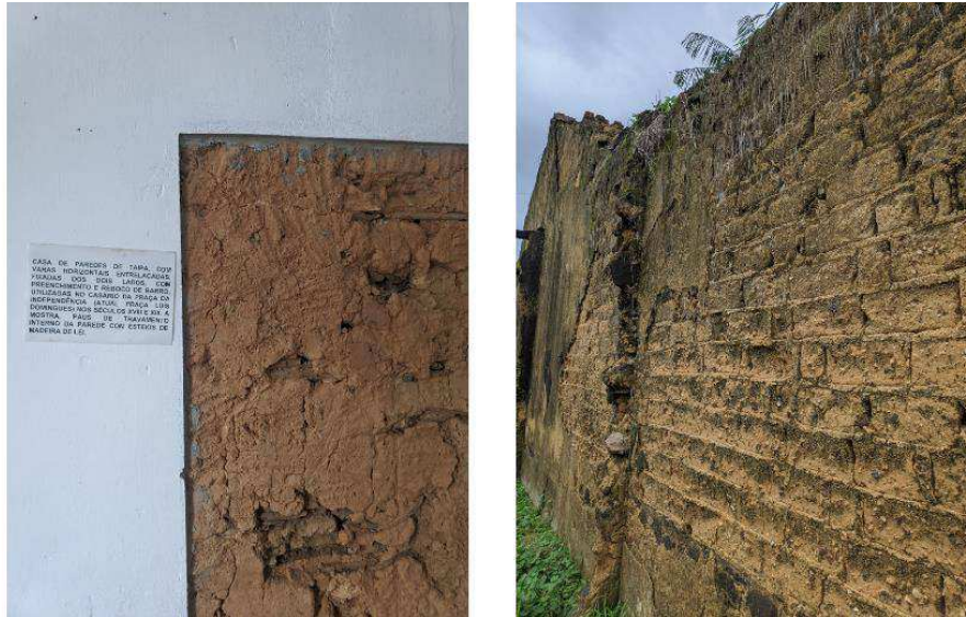
Figura 77. Paredes de taipa de pilão e adobe, respectivamente.
