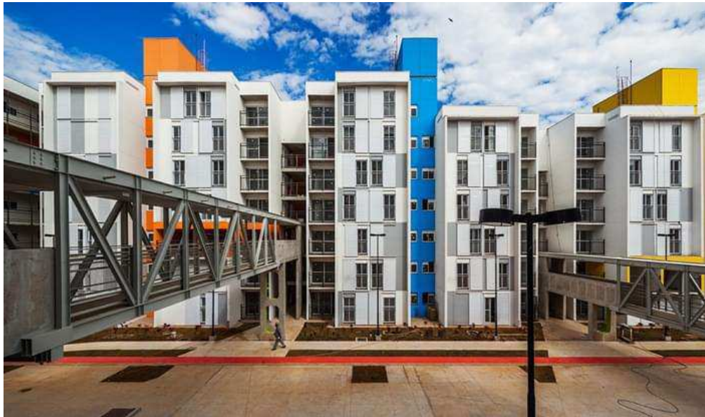
Figura 15 - Acessos e passarelas metálicas, Heliópolis
