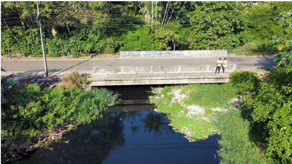
Figura 39 – Vista aérea do pontilhão
