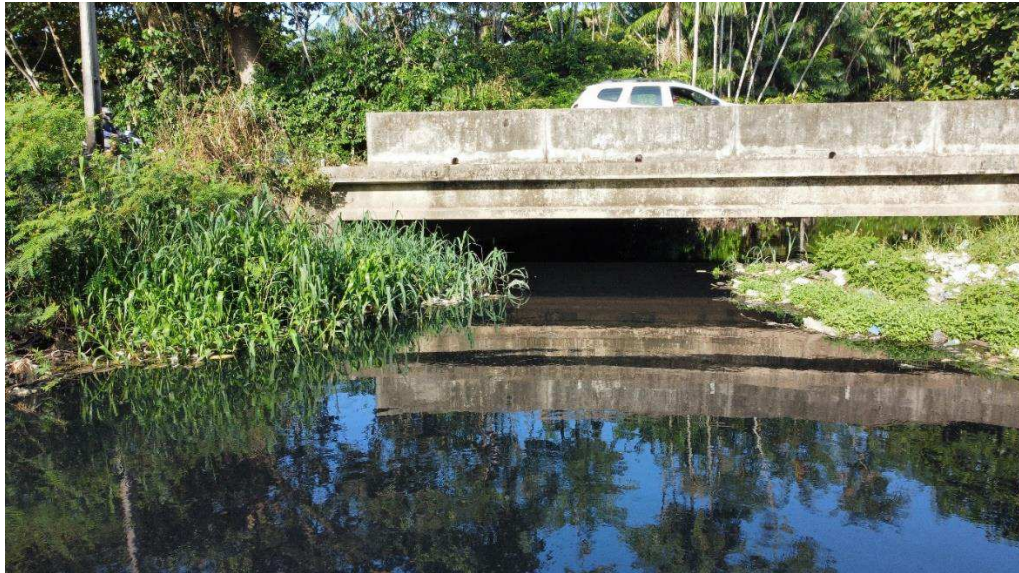
Figura 38 – Seção transversal de pontilhão após o delimitado para estudo
