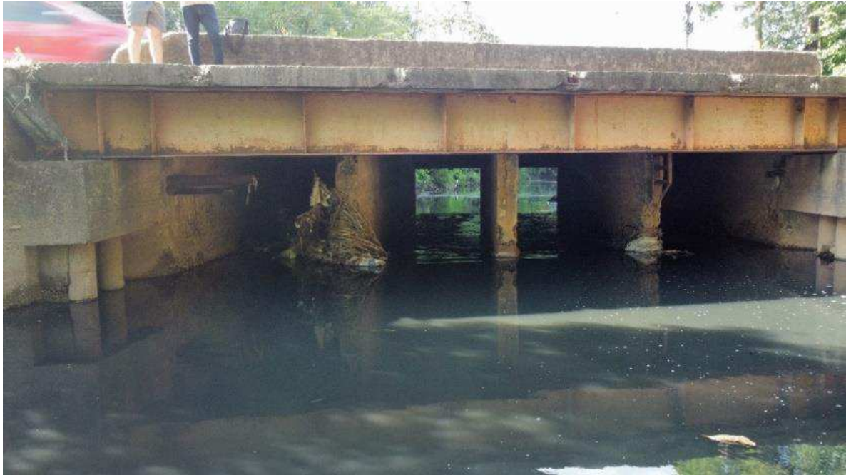
Figura 23 – Vista transversal da ponte de concreto da travessia
