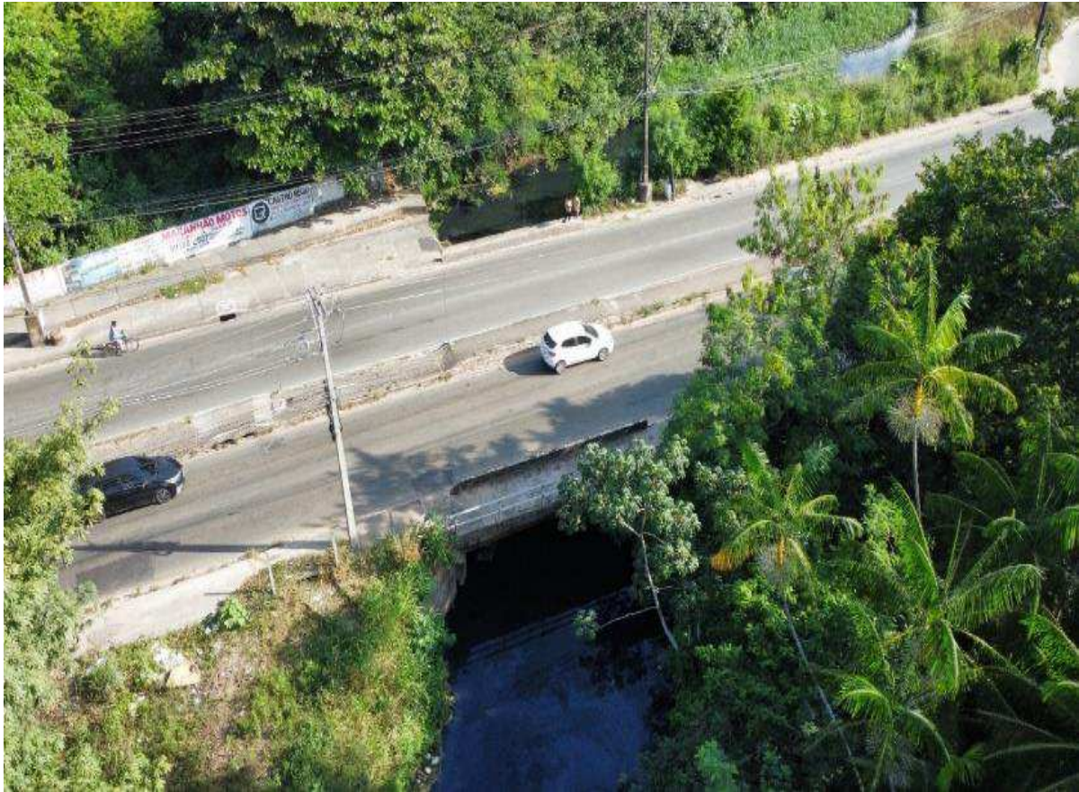
Figura 22 - Vista aérea da travessia da MA-201 com o rio Paciência
