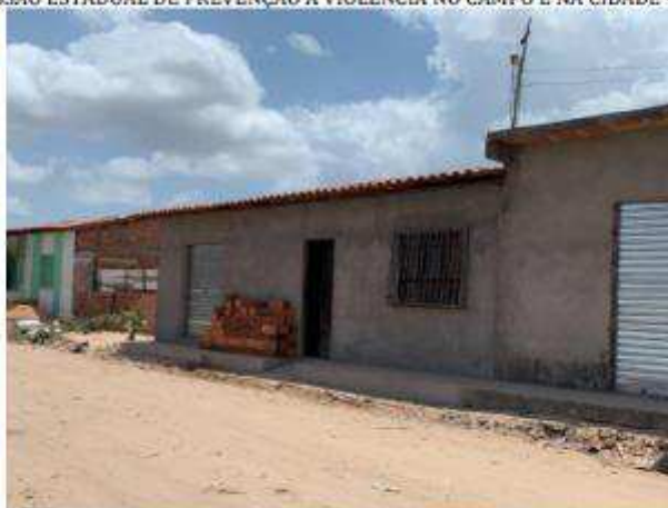
Figura 12: Casa de alvenaria
