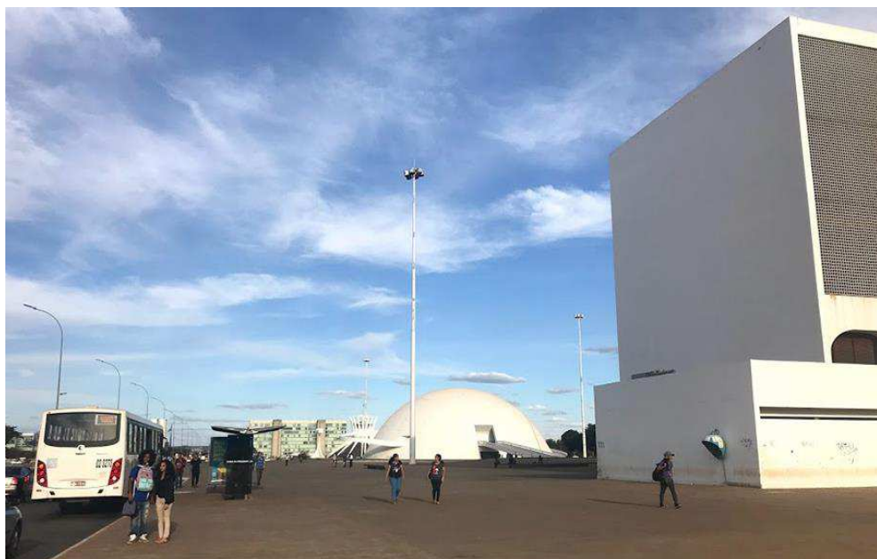
Figura 24 - Espaço voltado para pedestres, sem área permeável e sem arborização.
