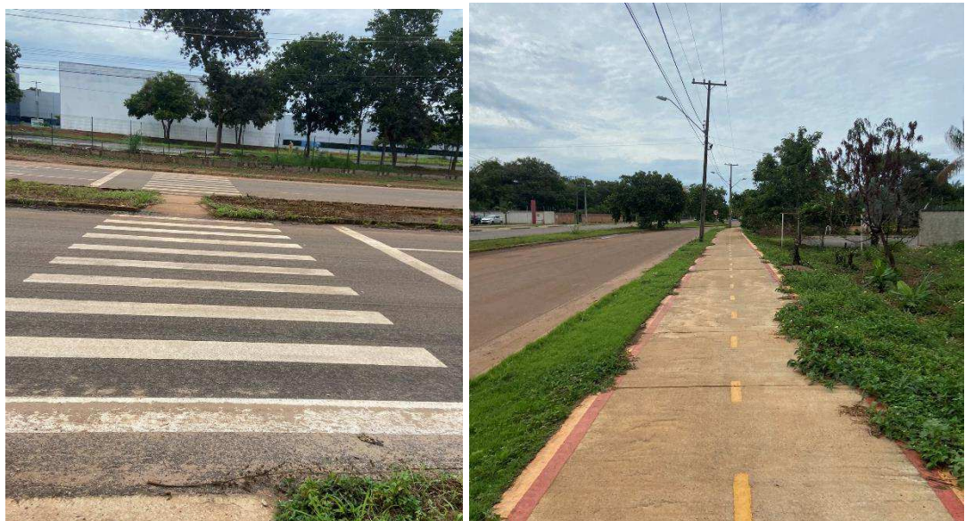
Figura 67 - Faixa de pedestre e ciclovia, quadra 1103.
