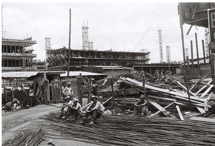
Figura 20 - Canteiro de obras nas superquadras de Brasília.
