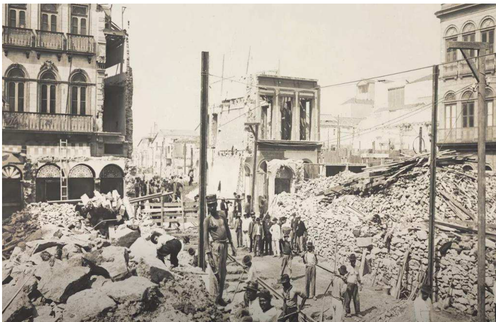
Figura 14 - Demolições durante o “Bota-abaixo”, Rio de Janeiro, 1904.
