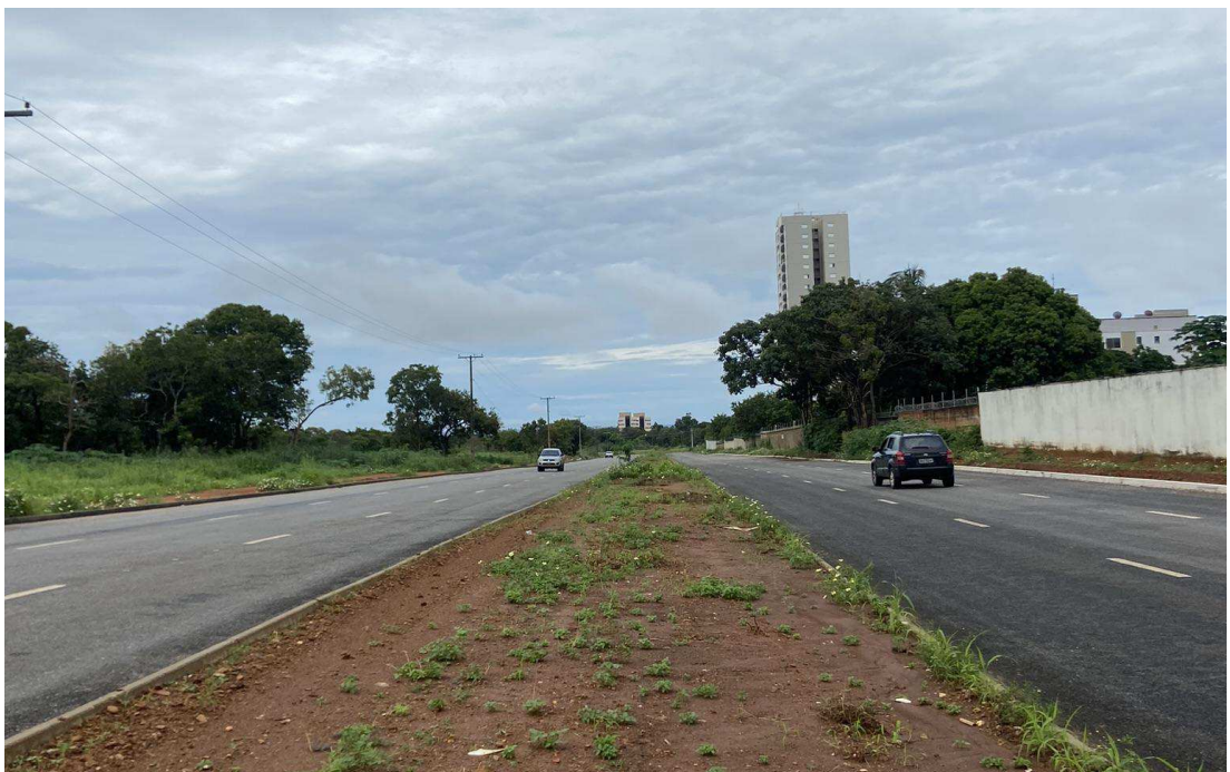
Figura 47 - Fotografia com vazio urbano (à esquerda) e fachada cega (à direita).
