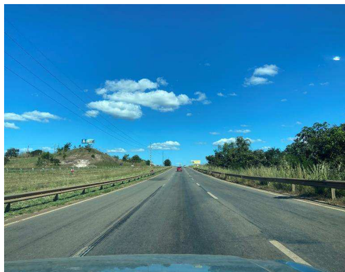
Figura 74 - Rodovia TO – 050, trecho rodoviário para Jardim Aurenly I.
