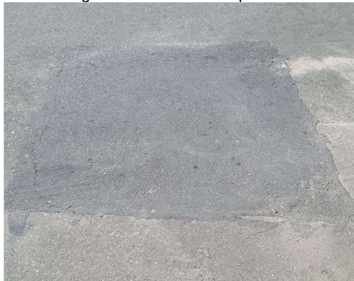
Figura 17 - Remendo superficial
