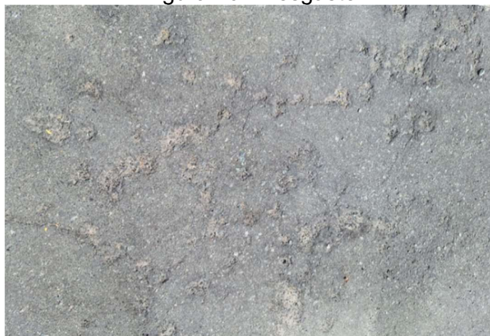
Figura 16 - Desgaste
